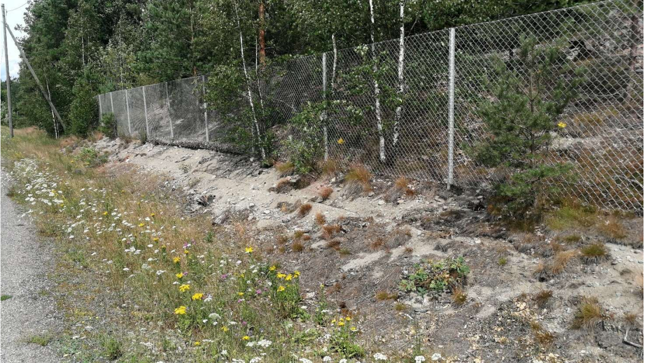
Kuva 5. Kasvillisuutta on poistettu luiskalta osa-alueella 2.
