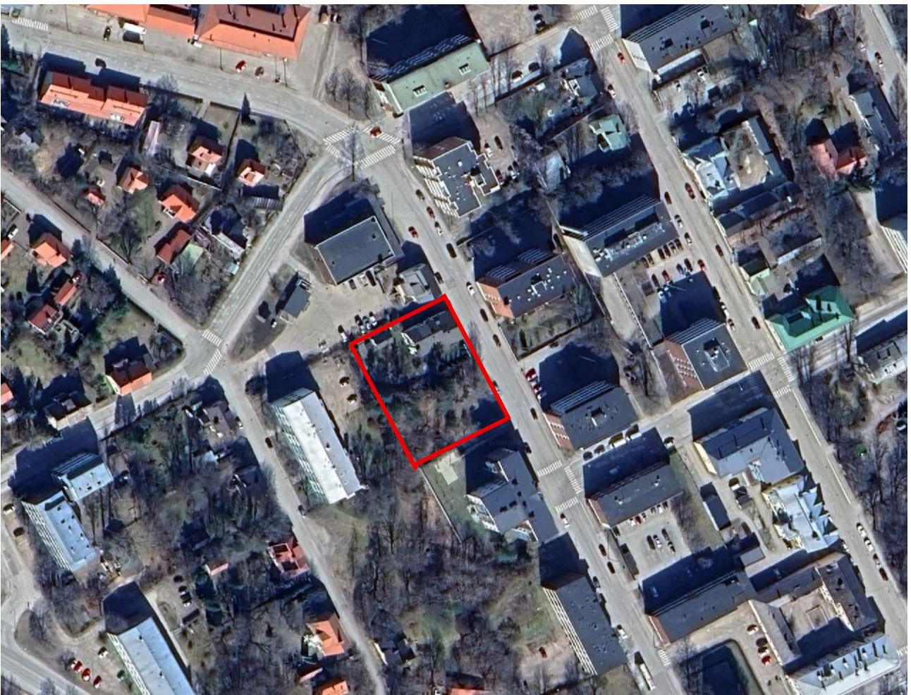
Planeringsområdet i sin närmiljö. I nedre högra hörnet syns skuggan från kyrktornet. Området befinner sig i ett brytningsområde mellan flervåningshus och äldre egnahemshus.
