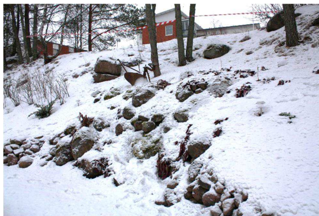
AKDG5145:21 Sannolikt ursprunglig stödmur i vallens sydöstra sida. Från nordväst. Foto Katja Vuoristo.
