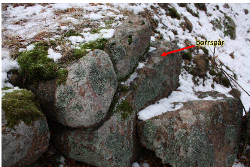
AKDG5145:14 Detalj från stensättningen i den sydvästra sidans stödmur. Den norra delen. I den mellersta stenen urskiljs ett långsgående borrarspår. Från nordväst. Foto Katja Vuoristo.
