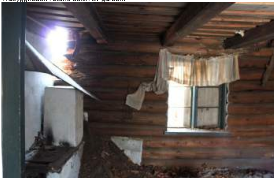
Bild 36. Träbyggnaden inifrån med vy mot tamburen.
