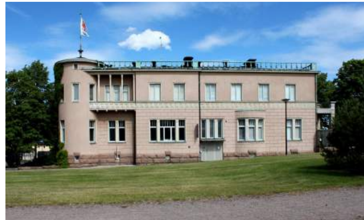
Bild 30. Västra fasaden. I samband med ändringarna på 1960-talet gjorde man en öppning i väggen för ytterdörren i mitten. Dörren förnyades nyligen, såsom också ytterdörren till källaren.
