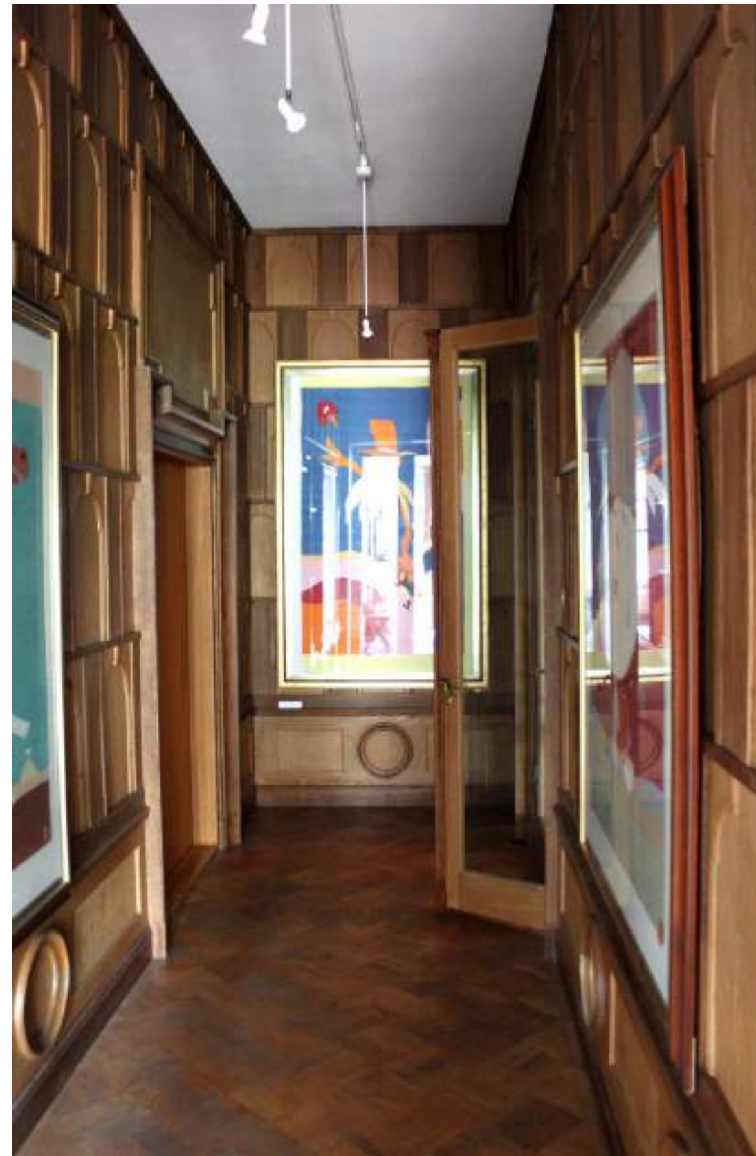
Bild 23. Vy från vinterträdgården till korridoren, som ursprungligen varit en del av salen till vänster. Korridoren som byggdes vid sidan av ombyggnadsarbetena är fodrad med träfodringsskivor från salen. Huvudtrappan till höger.
