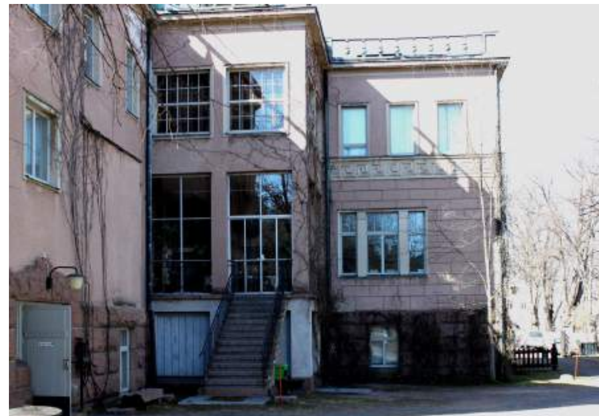
Bild 31. Inre hörnet mot innergården. De nuvarande ägarna har låtit glasa in den öppna verandan. Utanpå den ligger vinterträdgården. Till vänster en förnyad dörr som leder via källaren in till huset.
