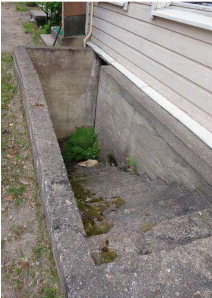
Tomt 36 Byggnad R1 trappa till källaren.
