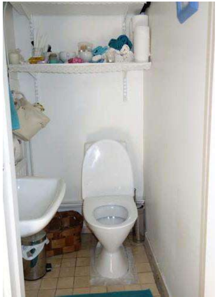
Tomt 36 Byggnad R1 befintliga våtrum.
