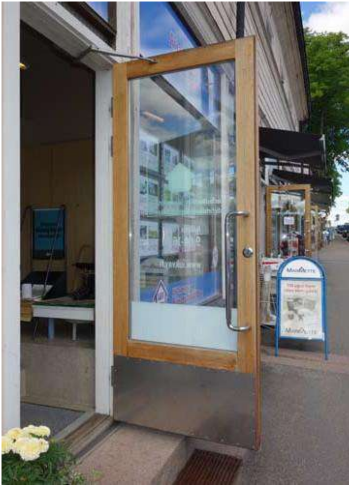
Tomt 36 Byggnad R1 nya dörrar till butikslokalerna
