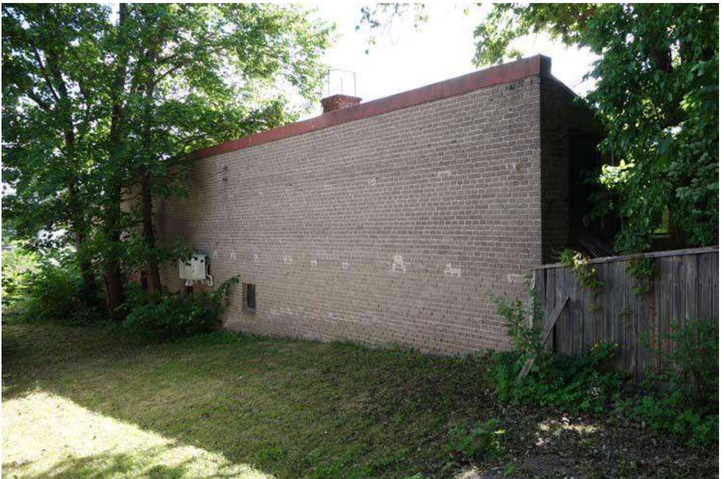
Tomt 37 Byggnad R6 brandmur.
