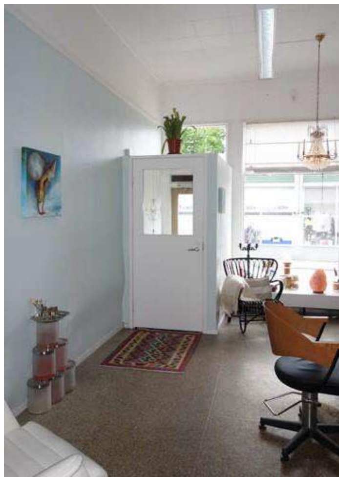
Tomt 36 Byggnad R1 vy över butikslokal.
