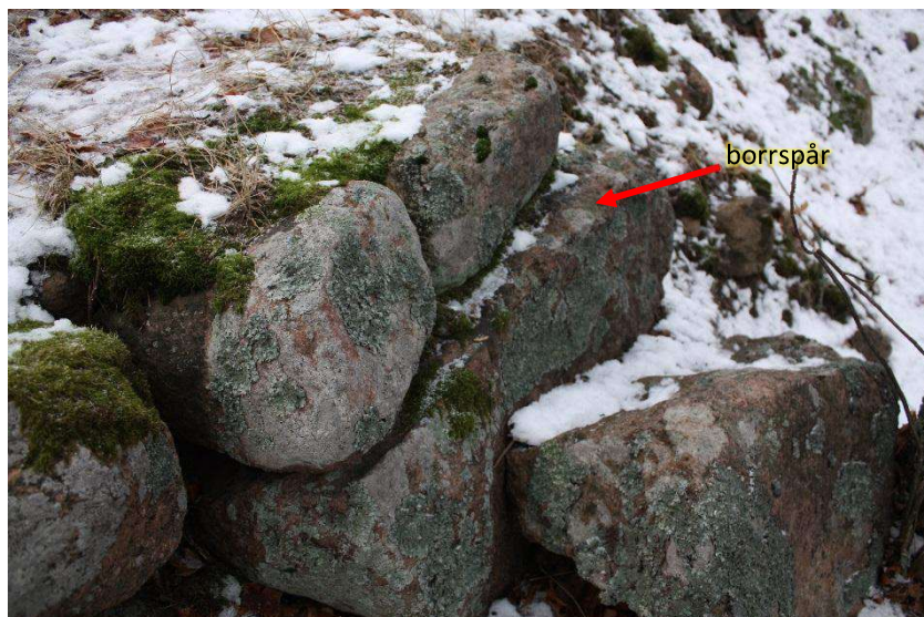
AKDG5145:14 Detalj från stensättningen i den sydvästra sidans stödmur. Den norra delen. I den mellersta stenen urskiljs ett längsgående borrarspår. Från nordväst. Foto Katja Vuoristo.
