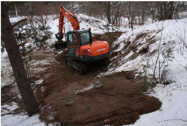
AKDG5145:23 Provdiket fylls igen. Från norr.
