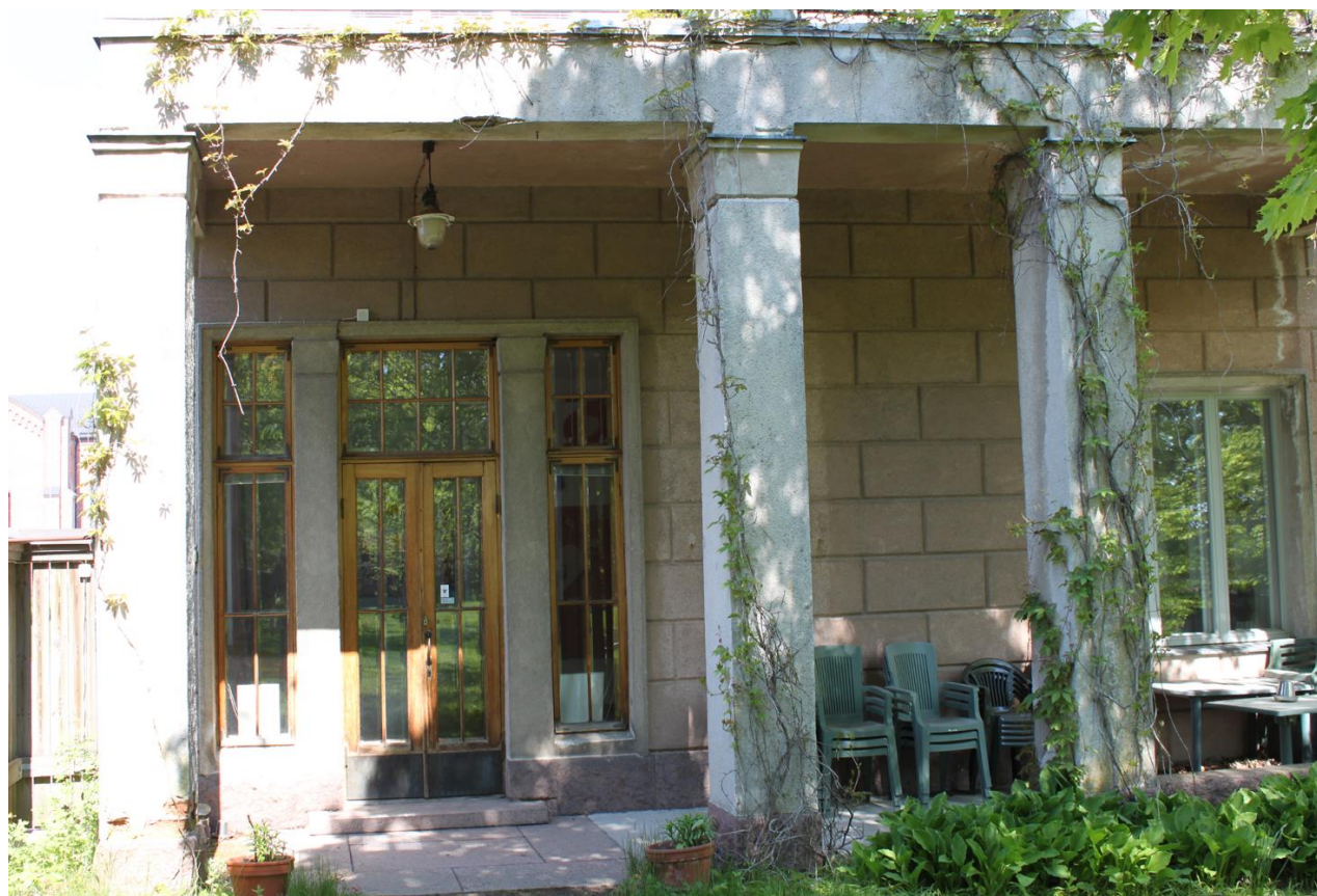
Bild 29.. Nedanom balkongen på gårdssidan finns en dörr av ek, fönster med bågar av ek och ett aluminiumfönster.
