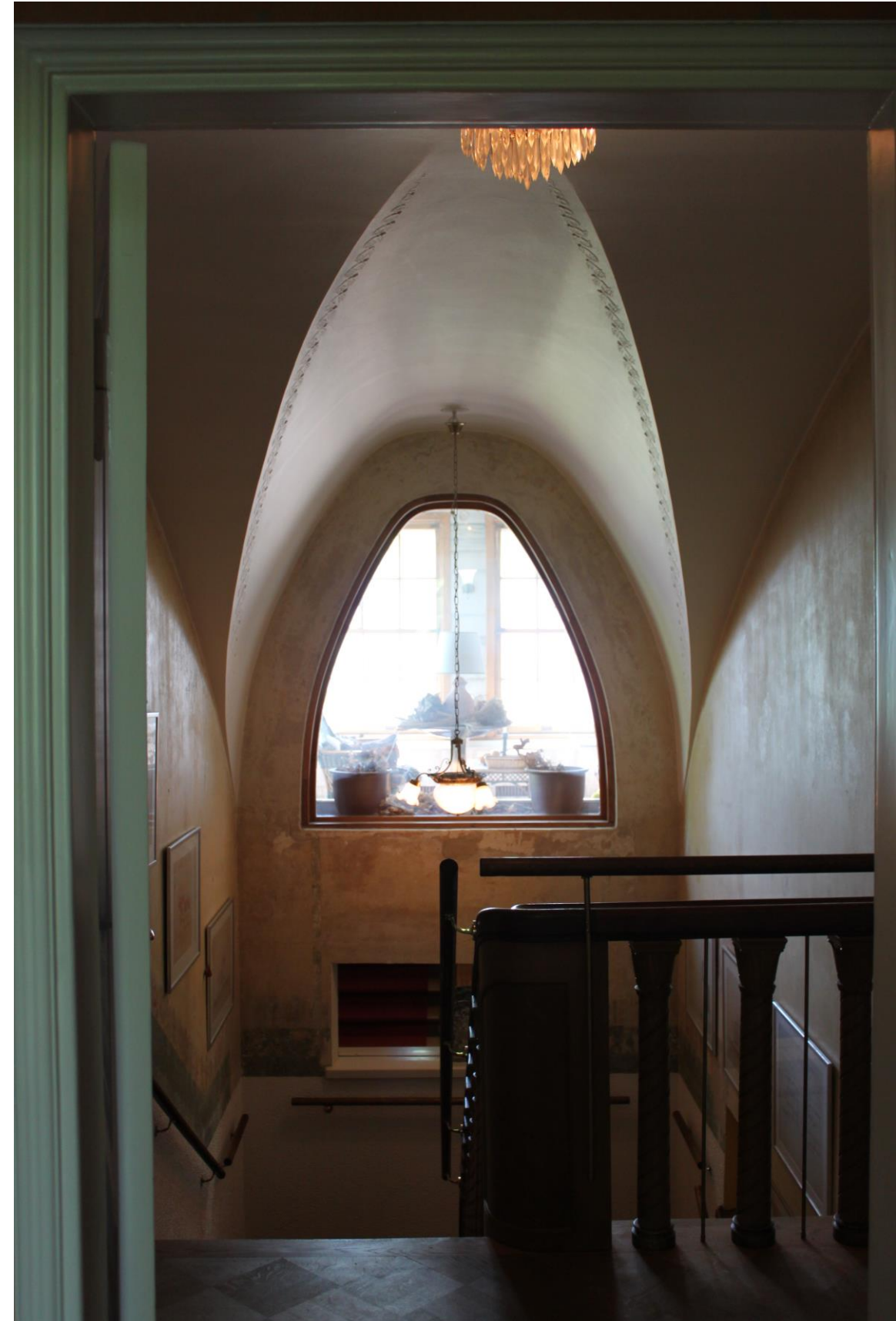
Bild 21. Trappa från hallen till andra våningen. Från övervåningen har man utsikt mot vinterträdgården. Det bågformade fönstret och valvets ornamentsmotiv tyder på jugenderan. Den skrovliga målningen har avlägsnats från väggens övre del och den gulgröna putsen som kommit fram under målningen har bibehållits.
