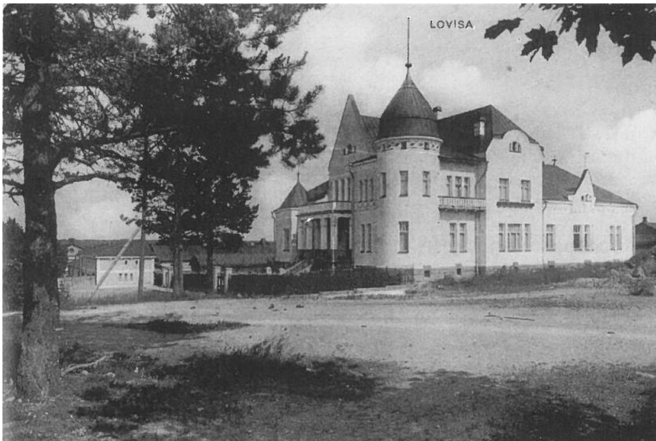
Bild 8. Villa Lovenetzky i ursprunglig skrud. Taket var högt och invecklat till sin form, entrén hade framhävts med ett högt gavelfält. Byggnadens dimensionering och öppningarna i fasaden framhäver det vertikala uttrycket. På båda sidorna om det runda tornet sänker sig byggnaden så att den har en våning. Framför entrén finns en rak trappa.
