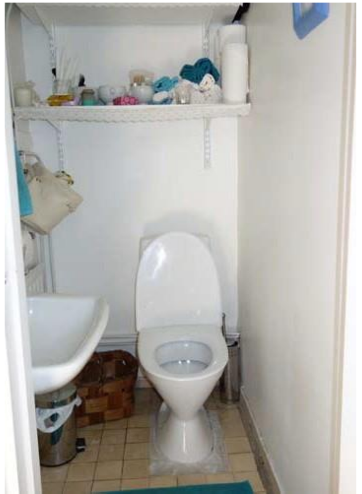
Tomt 36 Byggnad R1 befintliga våtrum.
