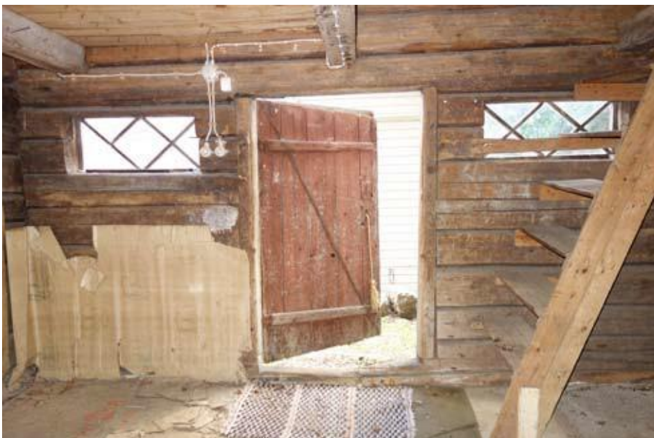
Uthuset som det ser ut idag, interiörbild av det tidigare stallet. .
