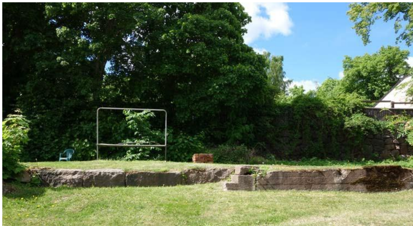
Byggnad R8 stengrund på gården.
