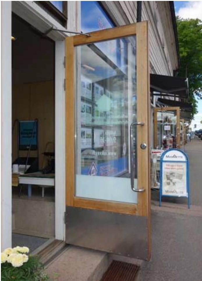
Tomt 36 Byggnad R1 nya dörrar till butikslokalerna
