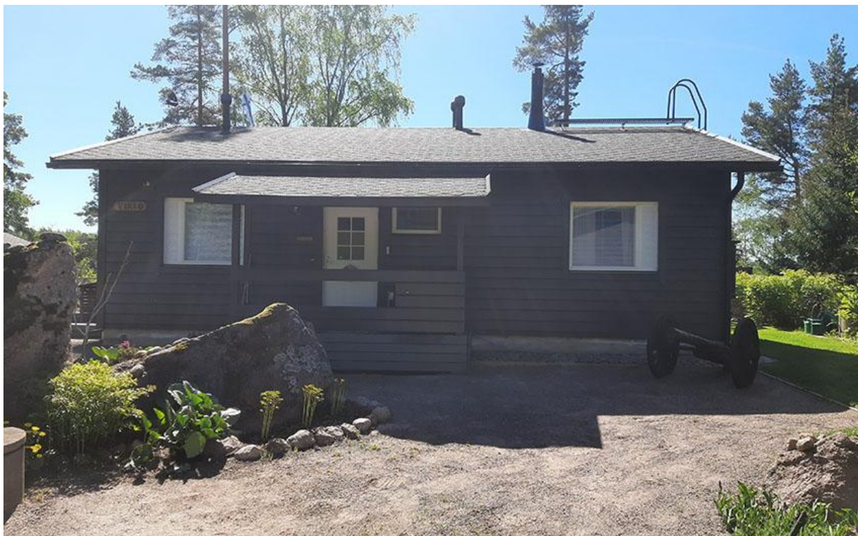
Bild 13. Fritidsbostadens fasad mot norr.
