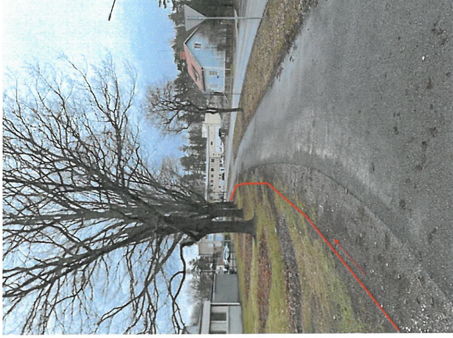
Kirkkokatu kaapelointi suojaputkeen viherkaistalle etäisyys puista huomioiden
