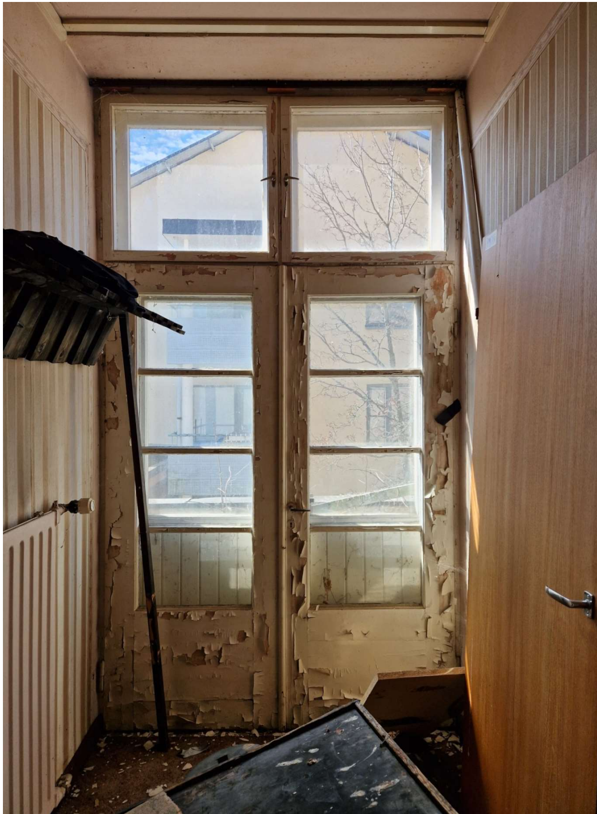
Kuva 49. Hotellikäytävän länsipäädyn ovi.
