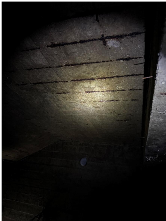
Kuva 11: Välipohjalaatan raudoitusvaurioita.
