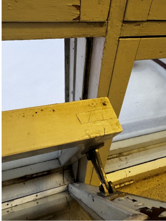
Kuva 30: Ikkunoiden tiivistyksissä ei havaittu merkittäviä puutteita.
