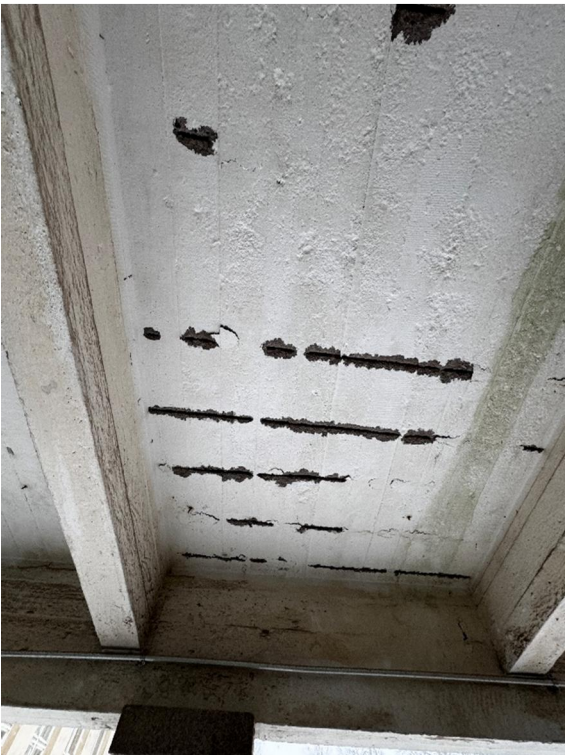
Kuva 22: Sisäpihan sisäänkäynnin katoksen raudoitevaurioita.
