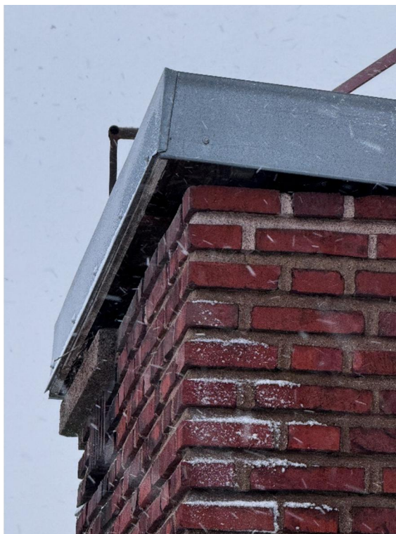
Kuva 34: Irronnut räystäsrakenne.
