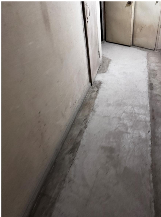
Kuva 13: Yleiskuva kellarin lattiasta.
