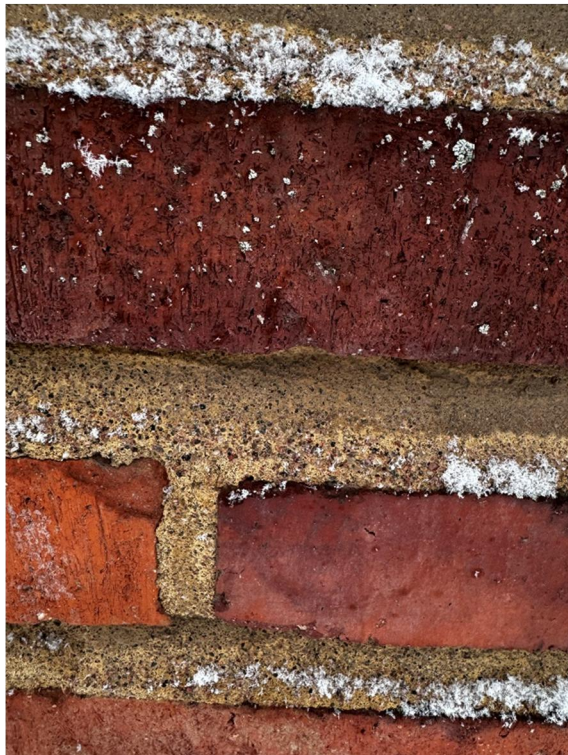
Kuva 19: Muuraussaumoja oli korjattu aiemmassa vaiheessa.
