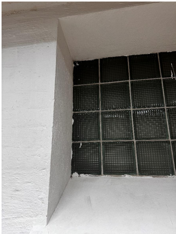
Kuva 12: Lasitiilet poistetaan.
