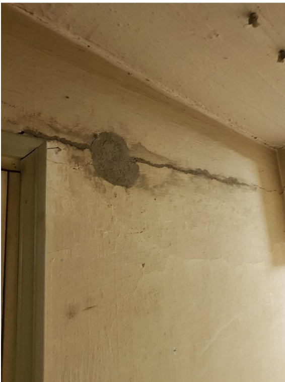
Kuva 10: Halkeama seinässä.
