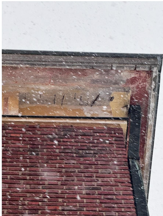
Kuva 22: Sisäpihan sisäänkäynnin katoksen raudoitevaurioita.
