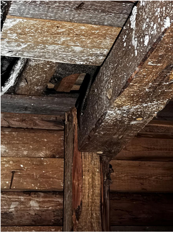
Kuva 28: Kosteusvaurioita puurakenteissa.
