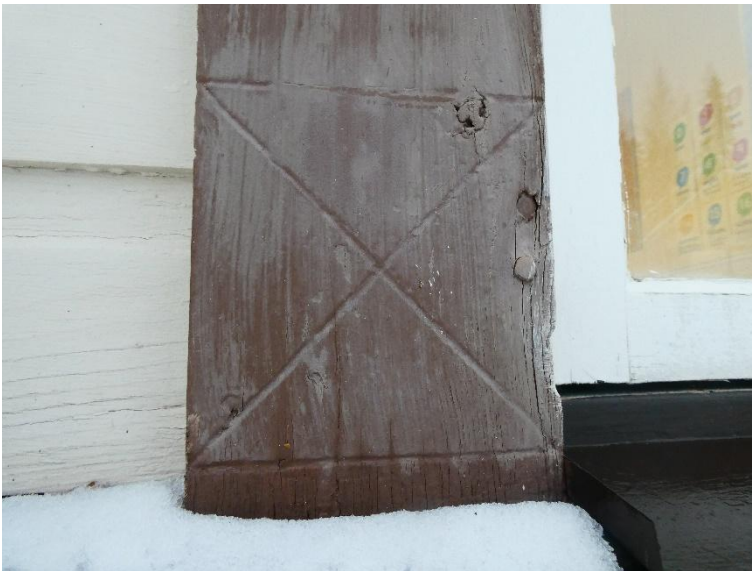
Kuva 16: Kuviointia ikkuna-aukon laudoituksessa.
