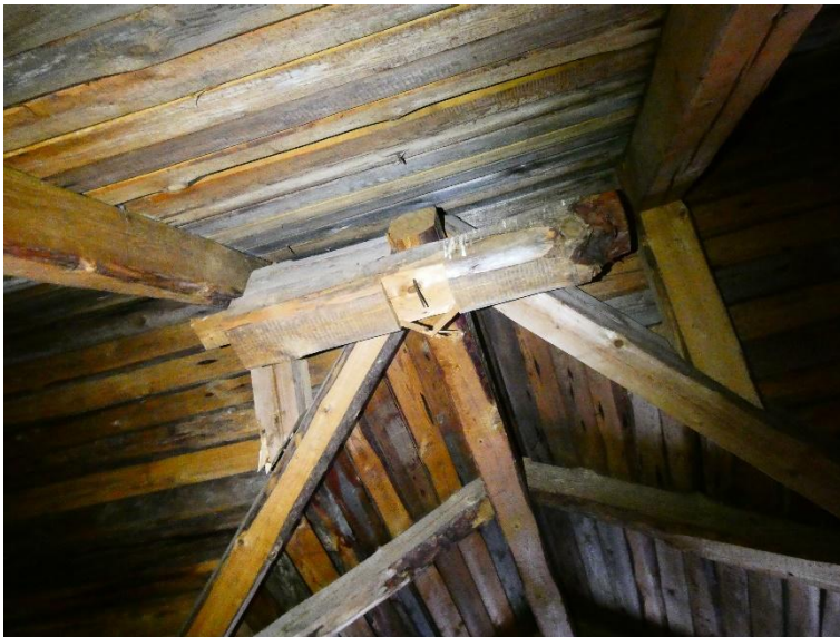
Kuva 29: Pilari oli poistettu.
