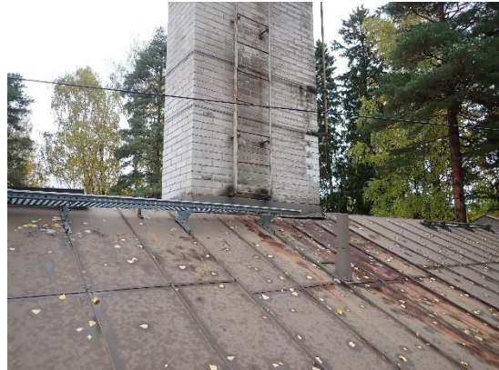
Kuva 28. Yleisnäkymä keittiö/asunto osan vesikatolle
