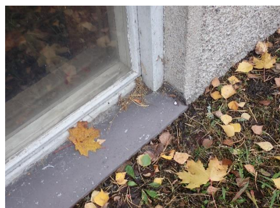
Kuva 17. Kellarin ikkunan liittymä perusmuuriin, lähellä maanpintaa
