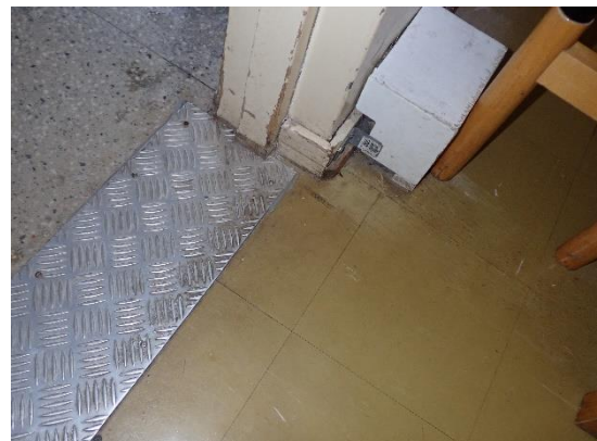
Kuva 12. Ala- ja välipohjarakenteen liittymänä ruokala/eteinen
