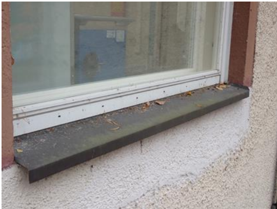
Kuva 20. Uuden ikkunan liittymä seinärakenteeseen
