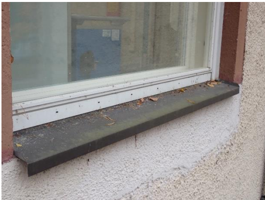
Kuva 15. Ikkuna madallettu keittiön osalla
