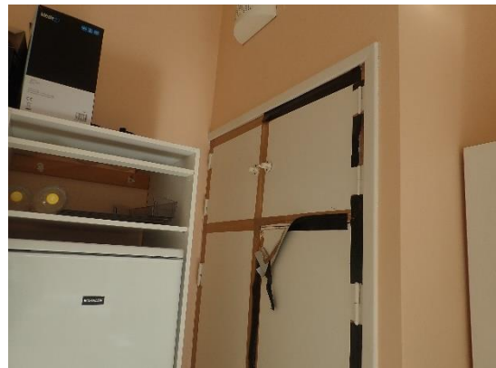
Kuva 24. IV pystykuiluna toimiva komeroryhmä vanhan keittiön nurkassa
