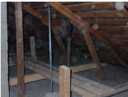
Kuva 33. Yleisnäkymä YP tilaan
