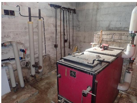
Kuva 5. Lämpökeskustila, kosteusjälkiä
