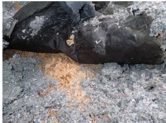
Kuva 38. Puhalluseristeen ja kutterilastueristeen välissä on bitumipaperi
