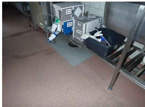
Kuva 26. Keittiön lattiaa korjattu
