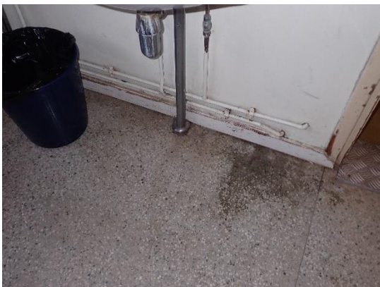
Kuva 11. Eteistilan alapohja, betonimosaikki pintalaatta
