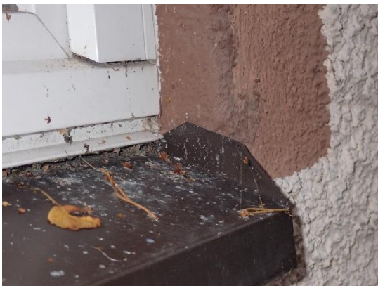
Kuva 16. Uuden ikkunan vesipeltiliitos
