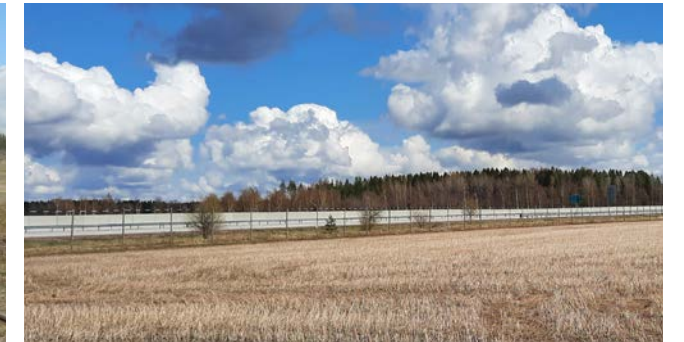
Moottoritien betoninen melueste.
