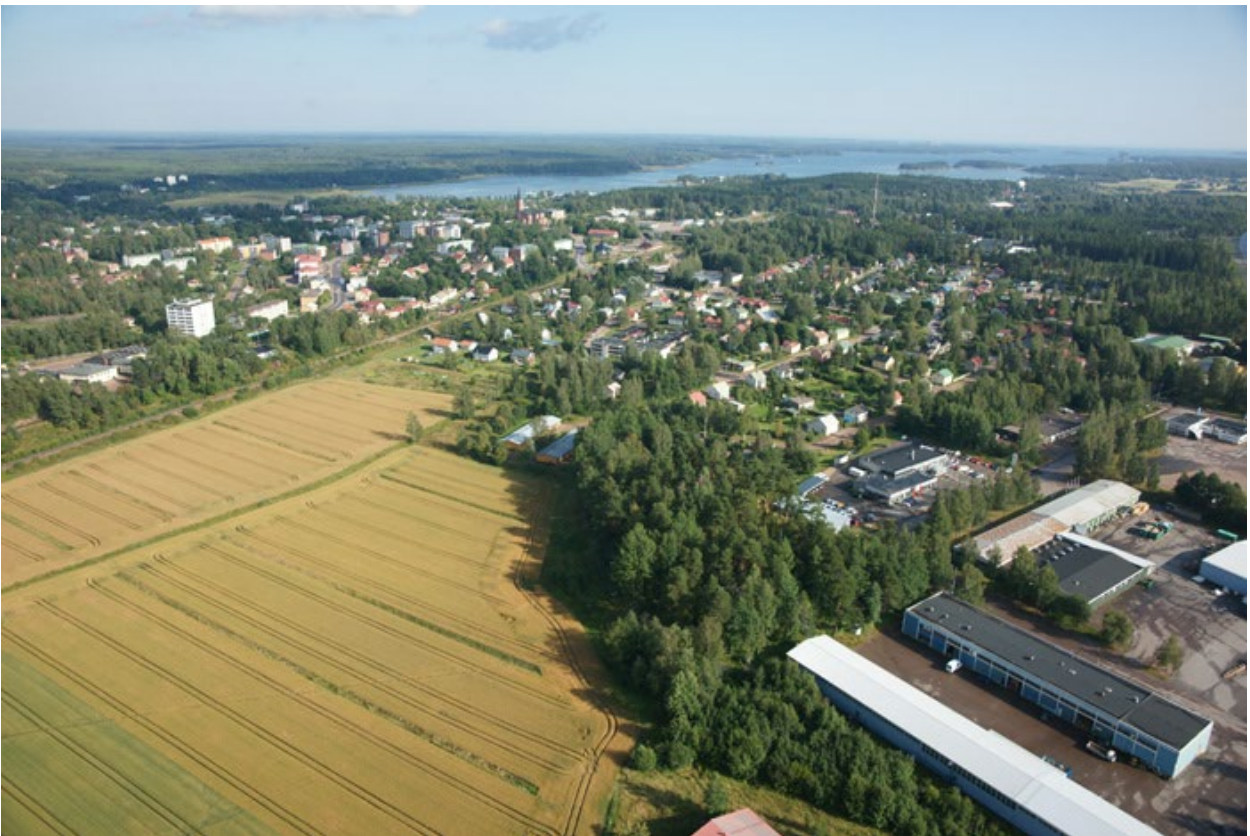
Bild 20. Flygbild från motorvägen mot sydost och Nystaden.
