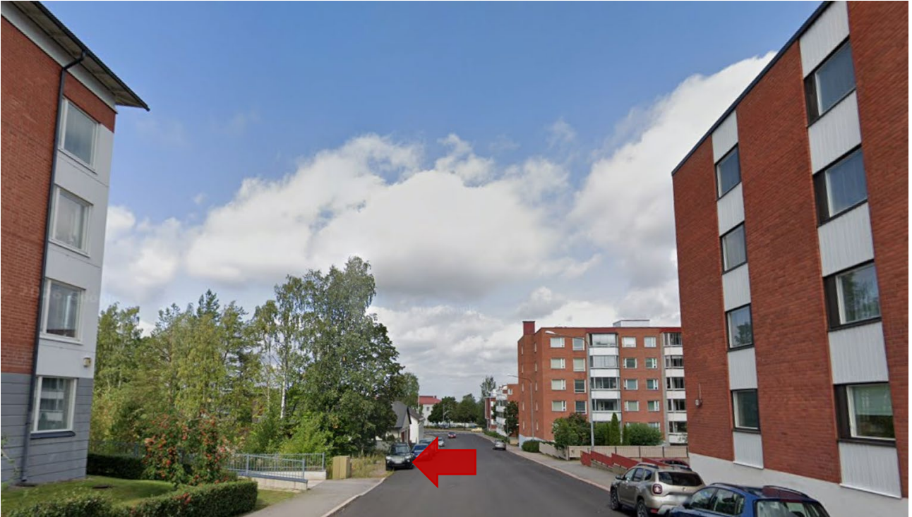
Kuva Chiewitzinkadulta pohjoiseen. Nuoli osoittaa suunnittelualuea. Naapurikiinteistön ramppi on rakennettu kiinni suunnittelualueen kiinteistönrajaan.
