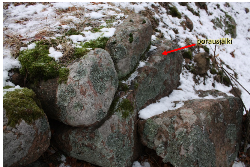
AKDG5145:14 Yksityiskohta lounaissivun tukimuurin kiveyksestä. Pohjoisempi osa. Keskimmäisessä kivessä erottuu pitkittäinen porausjälki. Luoteesta. Kuva Katja Vuoristo.
