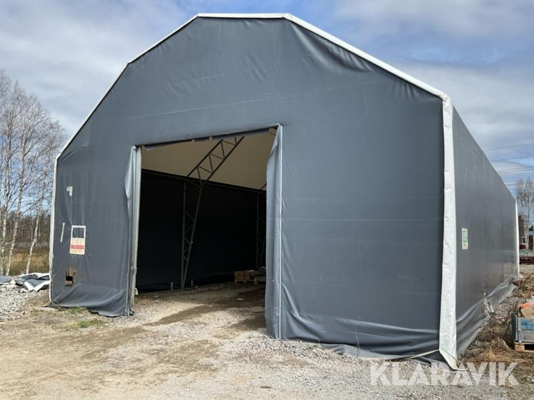
Pressuhall och containern för kompressorn, bilden längst ner.
