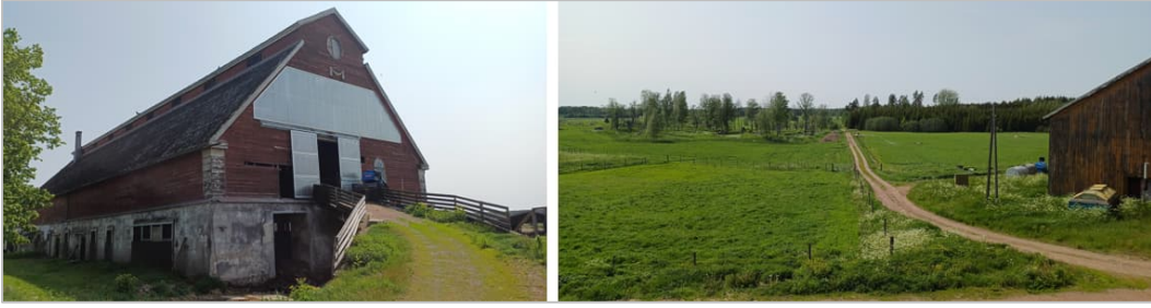
Kuva 2. Navetan julkisivut luoteeseen ja näkymä pellolle navetan ylisiltä. (Valokuvat: Kaija Maunula, kesäkuu 2025)
