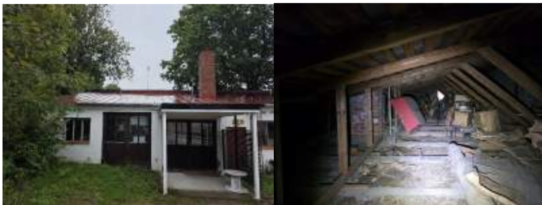
Kuva 2-1. Leipomorakennus 1 edestä (vasemmalla). Rakennuksen ullakkotila (oikealla).
