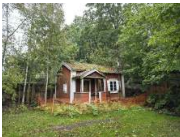
Kuva 2-3. Rakennus 3 (vanha asuinrakennus).
