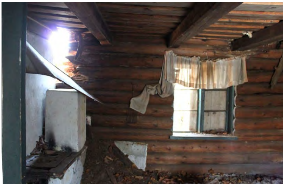
Kuva 36. Puisen rakennus sisältä kohti eteistä.
