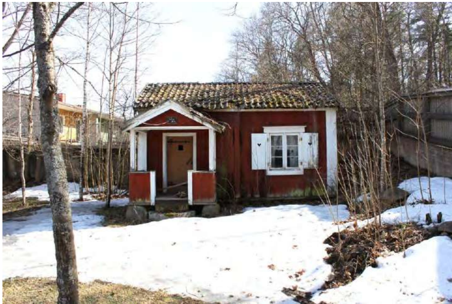
Kuva 35. Pihan perällä oleva puinen rakennus.
