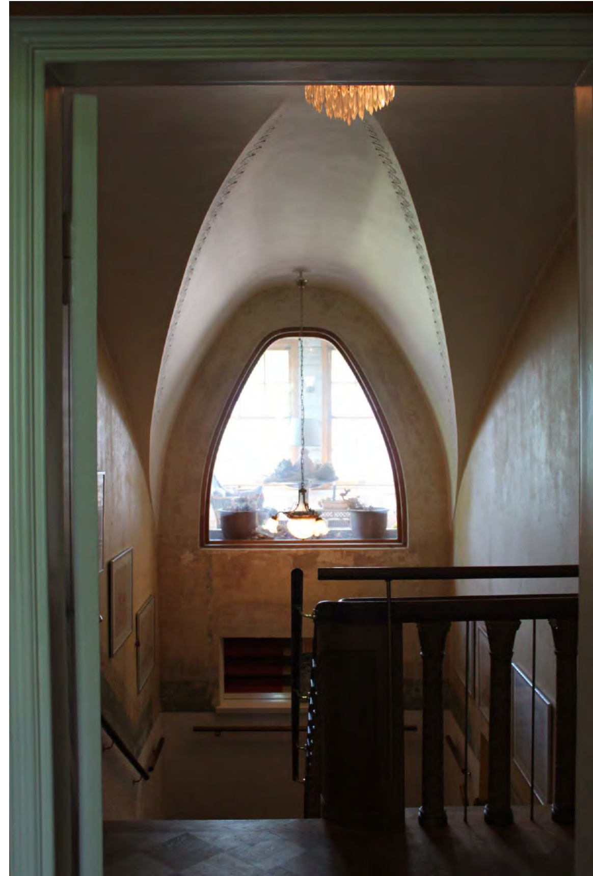
Kuva 21. Eteisestä toiseen kerrokseen johtava portaikko. Yläkerrasta on näkymä talvipuutarhaan. Portaan ikkunan kaarimuodot ja holvin koristeaiheet viittaavat jugend-vaiheeseen. Seinäpintojen rosainen maalaus on poistettu yläosaltaan. Alta paljastunut kelta-vihreä värirappaus on jätetty ennalleen.
