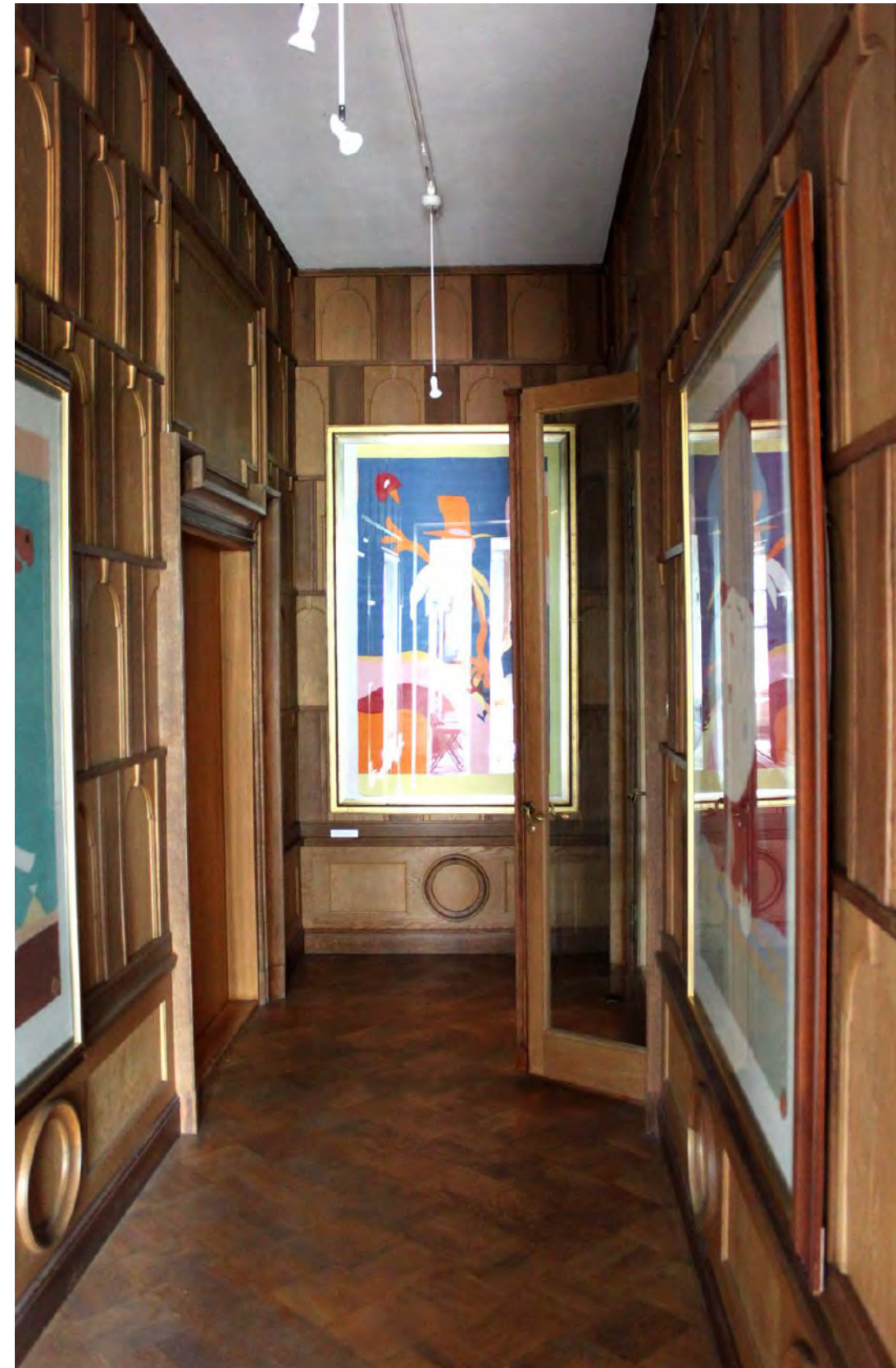
Kuva 23. Näkymä talvipuutarhasta käytävään, joka on alun perin ollut osa vasemmalle jäävää salia. Muutostöiden ohessa rakennettu käytävä on verhottu salista siirretyin puuverhouslevyihin. Oikealle jää pääportaikko.
