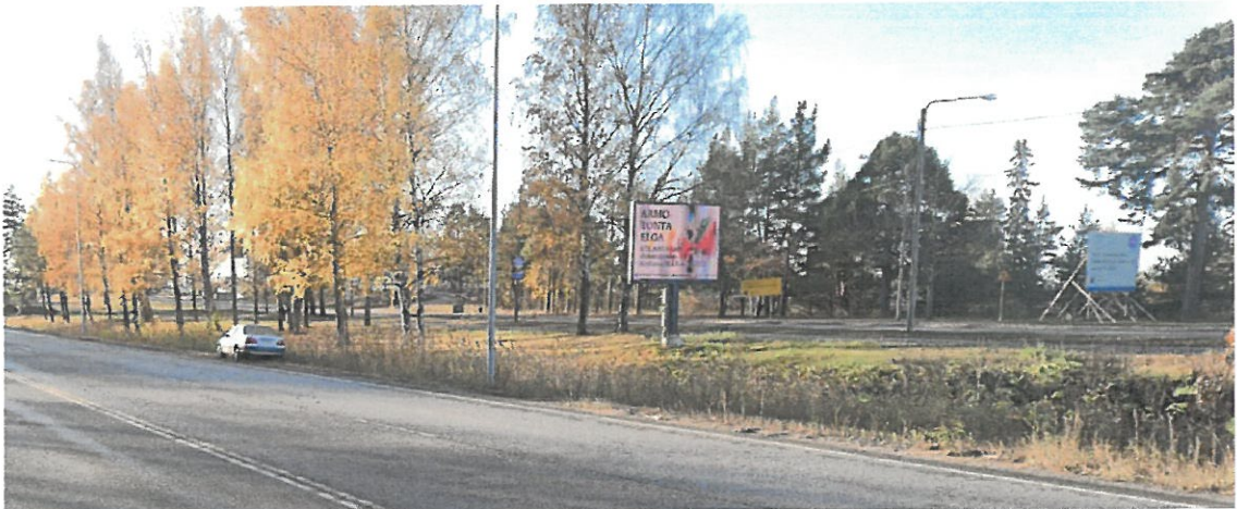
Esimerkki tyyppin 3 mainostaulusta. Hyvä esimerkki mainostaulusta, joka sijaitsee kahden tien välissä. Kuva: Kotka, Hyväntuulentie. Google maps. 13.3.2024
