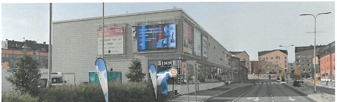
Esimerkki tyypin 2 digitaalisesta mainostaulusta. Mainoksen vaikutusta julkisivulle pitää tarkastella kokonaisuutena. Digitaalisen mainostaulun sijainti julkisivussa ei ole huono, mutta tekee yhdessä isojen mainosjulisteiden kanssa kokonaisuudesta levottoman. Kuva: Porvoon taidetehdas. Google maps. 13.3.2024
