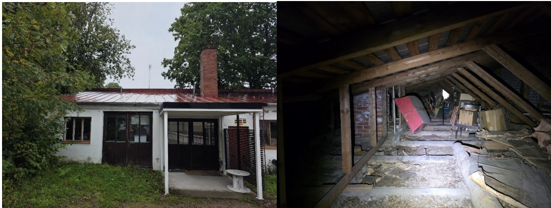
Kuva 2-1. Leipomorakennus 1 edestä (vasemmalla). Rakennuksen ullakkotila (oikealla).
