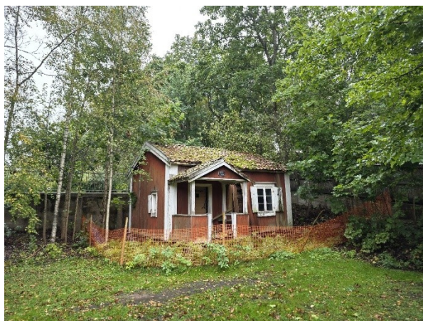
Kuva 2-3. Rakennus 3 (vanha asuinrakennus).
