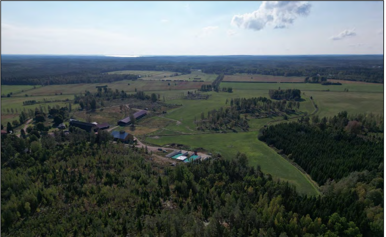
Kuva 8. Tilakeskuksen luoteisosassa on betonireunaisia aumarakenteita ja soranottoalue.
