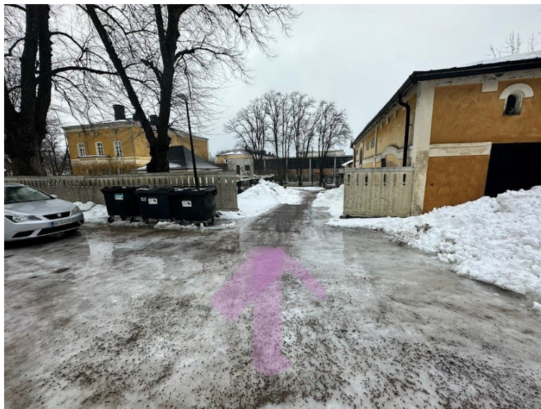
Kuva 2. Kadun reunakivi on jään peitossa, mikä mahdollistaa hulevesien virtaamisen korttelialueelle. (kuva: T. Raivio)
