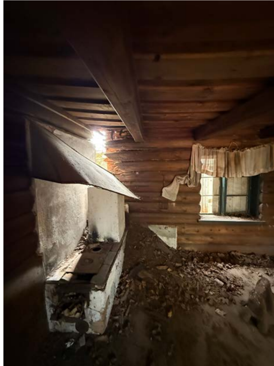
Kuva 2 Tuvan ovelta kohti kaakkoisseinää.
