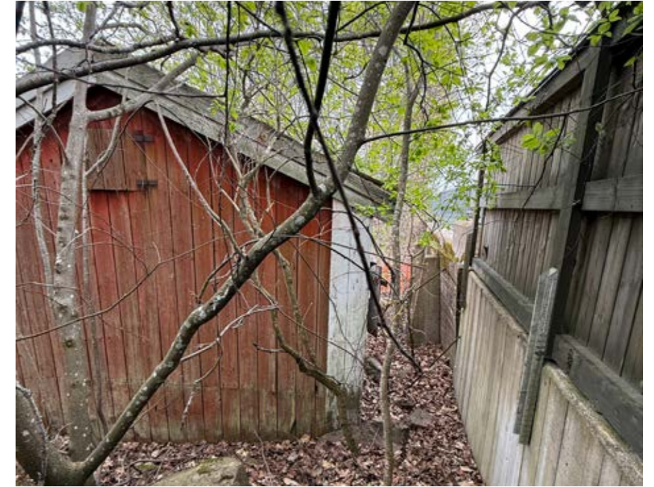
Kuva 2 Yleiskuva etelästä ylärinteen puolelta.
