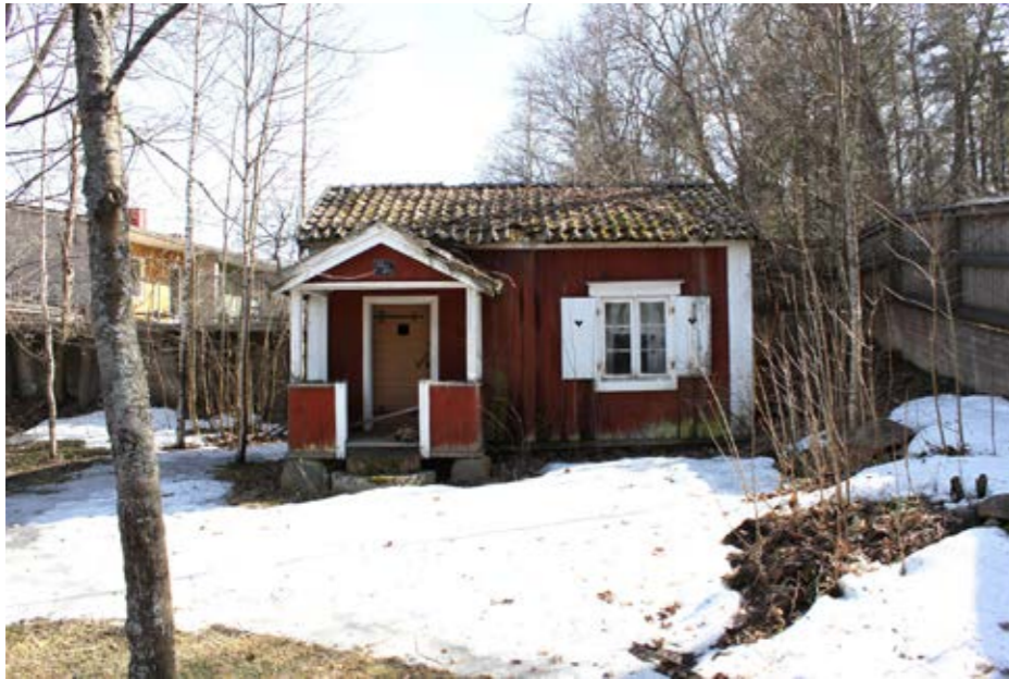
Kuva 35. Pihan perällä oleva puinen rakennus.
