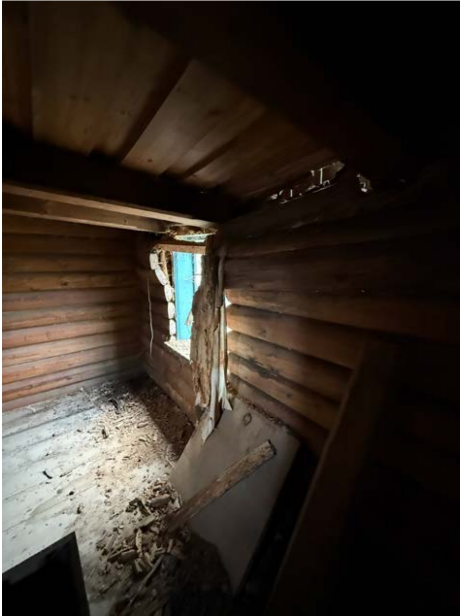
Kuva 1 Tuvan ovelta kohti länsinurkkaa, lattian luukku kuvan vasemmassa alakulmassa.
