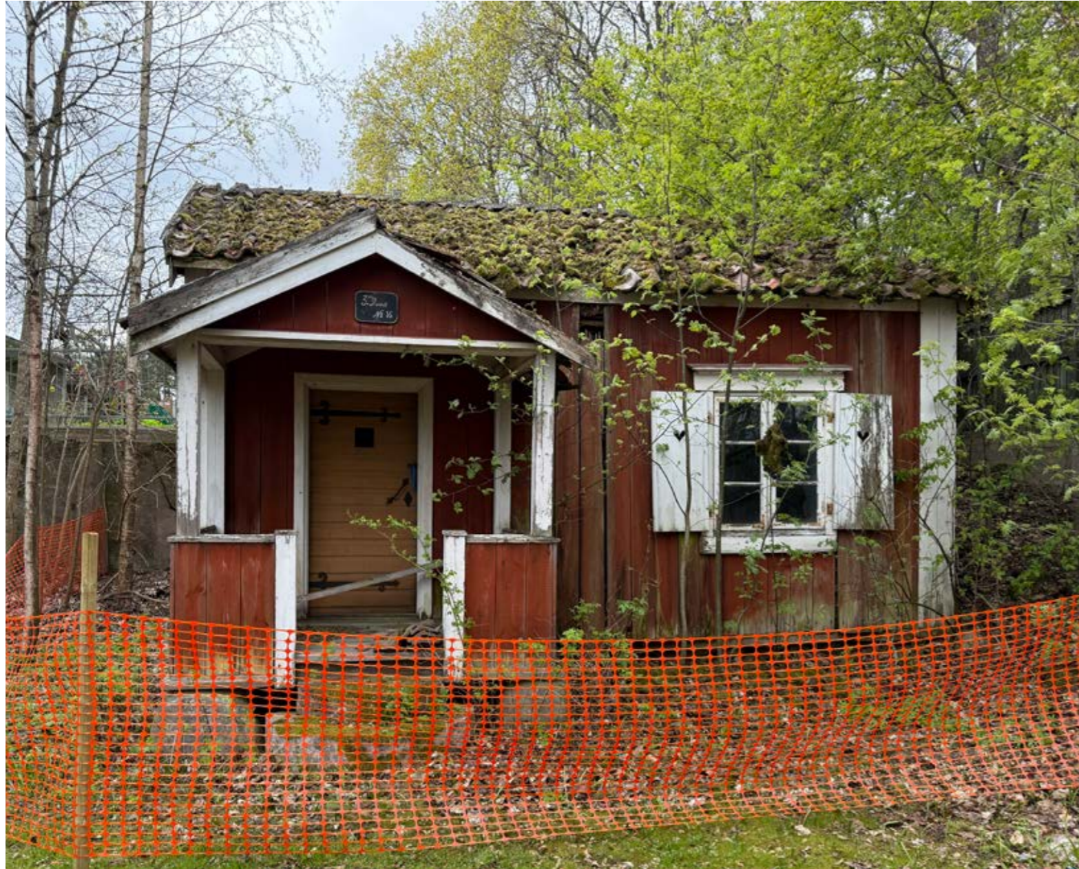
Kuva 1 Yleiskuva pääjulkisivusta. Rakennus eristetty sortumisvaaran vuoksi.
