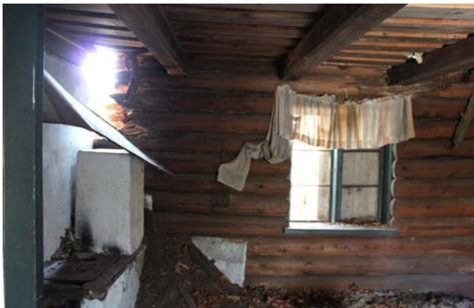
Kuva 36. Puisen rakennus sisältä.
