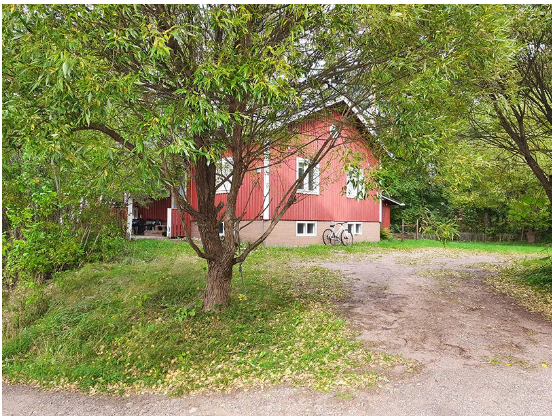
Kuva 5. Luoteisen rakennuspaikan omakotitalo.
