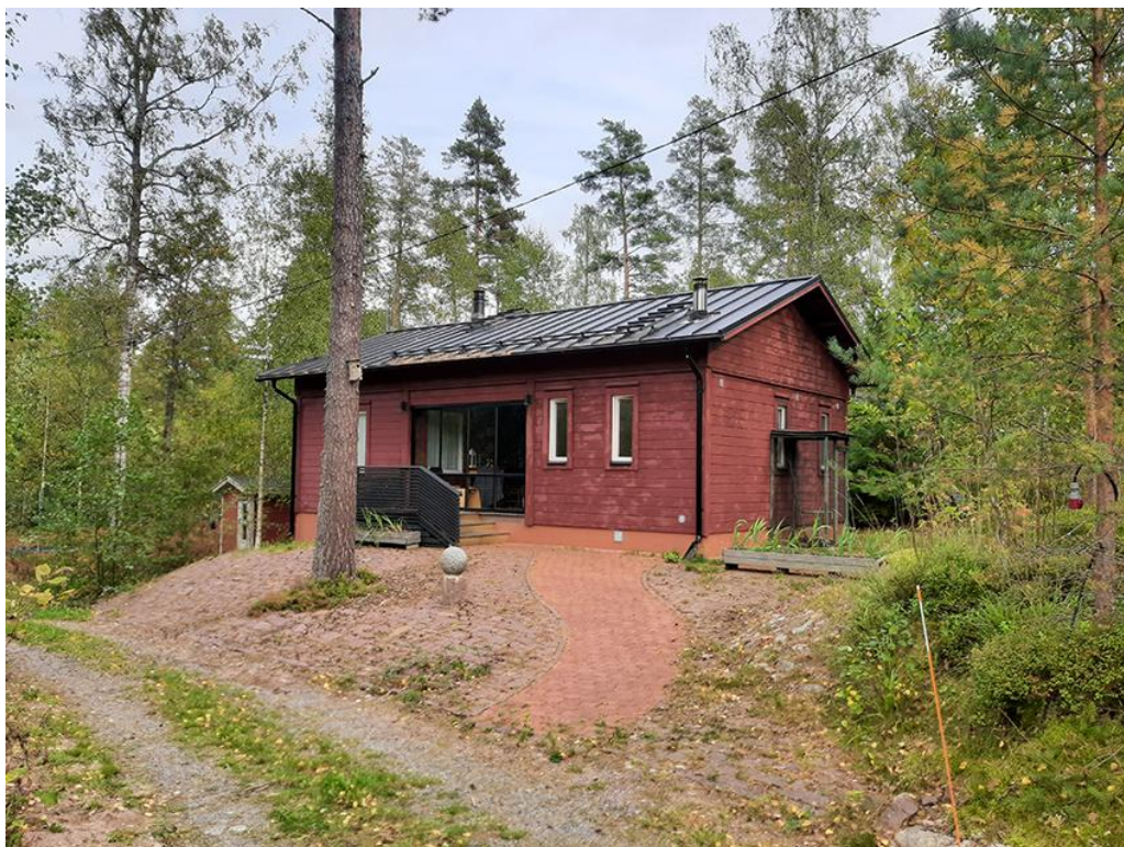
Kuva 1. Eteläisimmän rakennuspaikan (päärakennuspaikka) saunarakennus.
