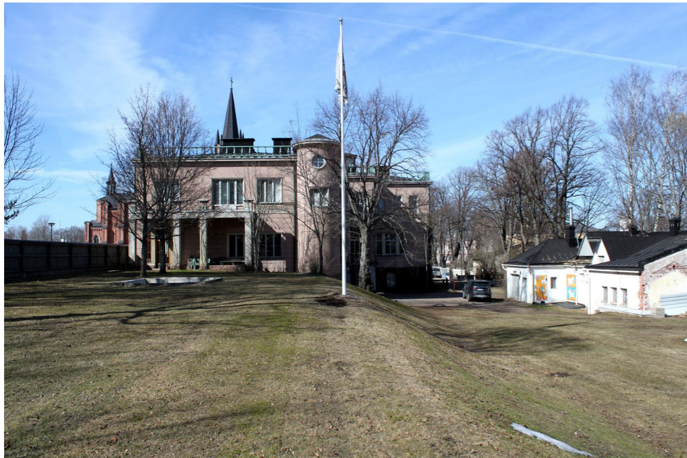
Kuva 32. Kuva pihalta, oikealla piharakennus.
