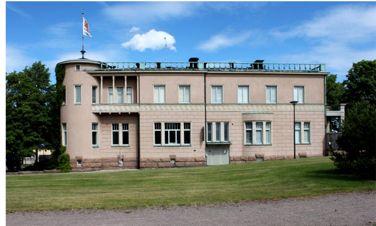
Kuva 30. Länsijulkisivu. Keksellä oleva ulko-ovi on puhkottu 60-luvun muutoksien yhteydessä. Ovi on uusittu äskettäin, samoin kellarin ulko-ovi.
