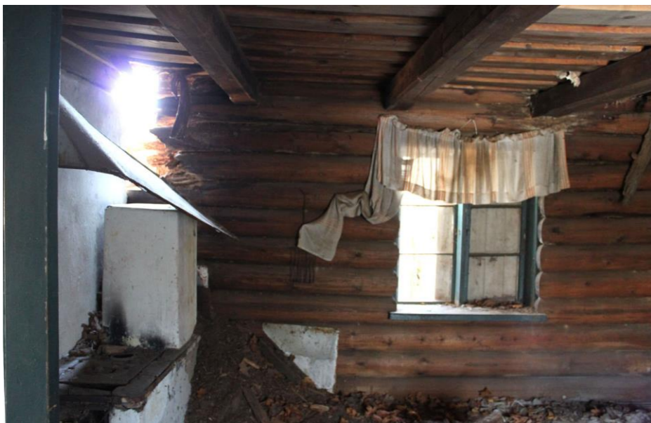
Kuva 36. Puinen rakennus sisältä kohti eteistä.
