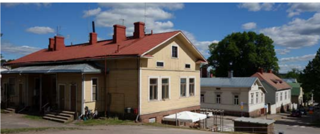
Rakennus R5 Pengermäkadun suunnasta nähtynä.
