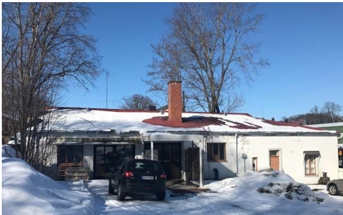
Rakennus R6 nykyasussaan sisäpihalta kuvattuna
