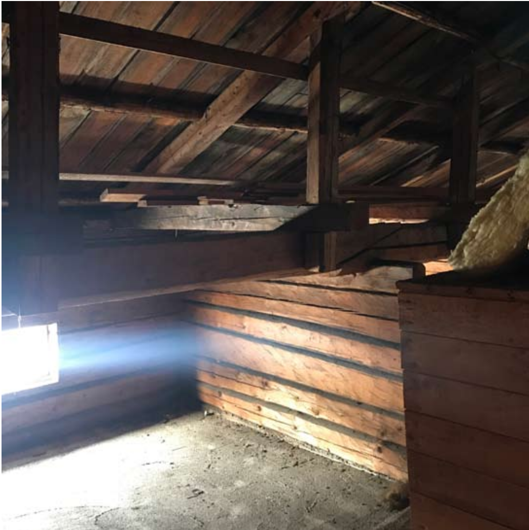
Valokuva tontti 36 päärakennus, ullakko. Muutostöiden yhteydessä lisätty betoninen välipohja selvästi nähtävillä.
