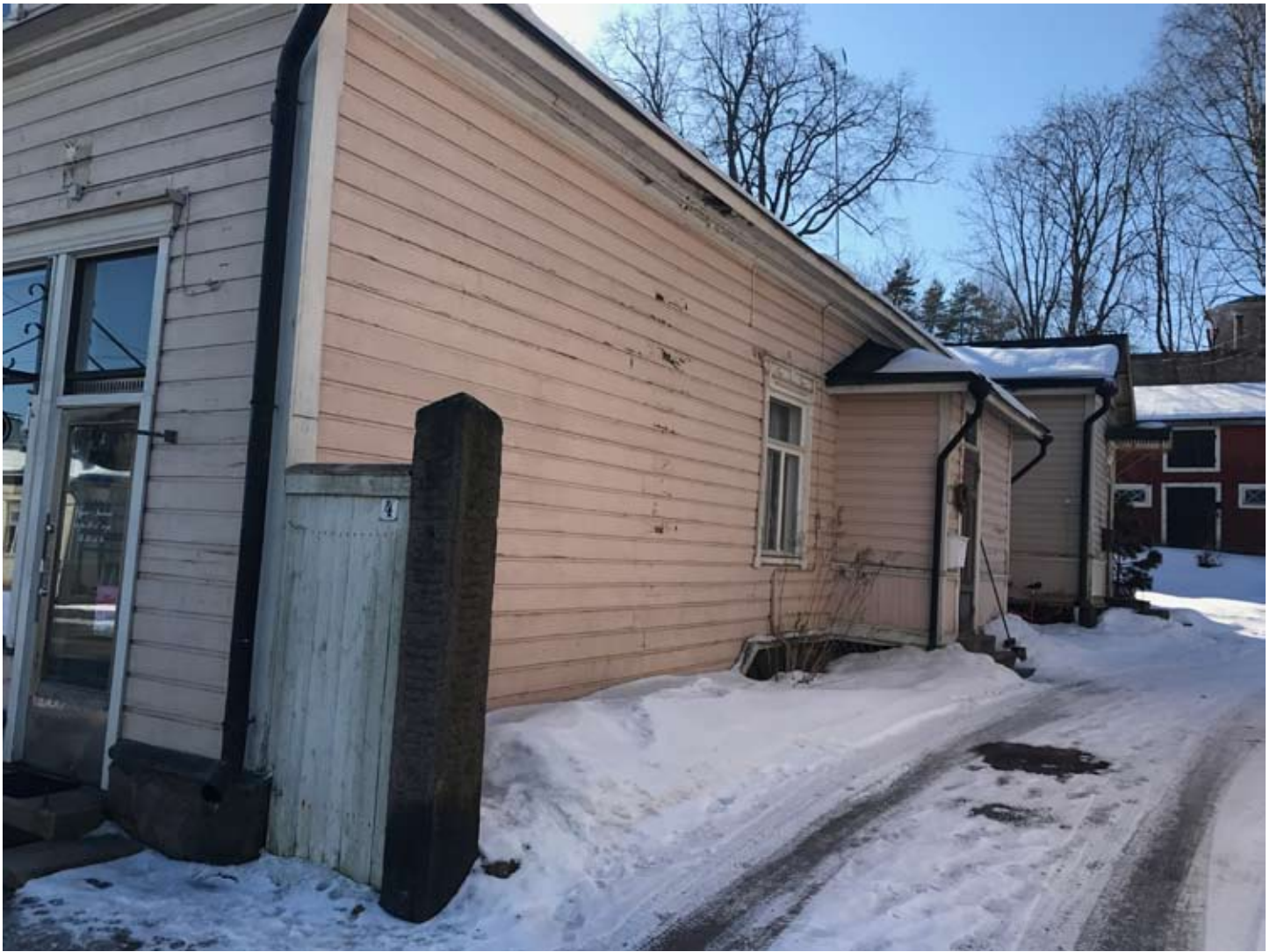
Tontti 36 Rakennus R2 sisäpihan puoli Aleksanterinkadun suunnasta nähtynä.
