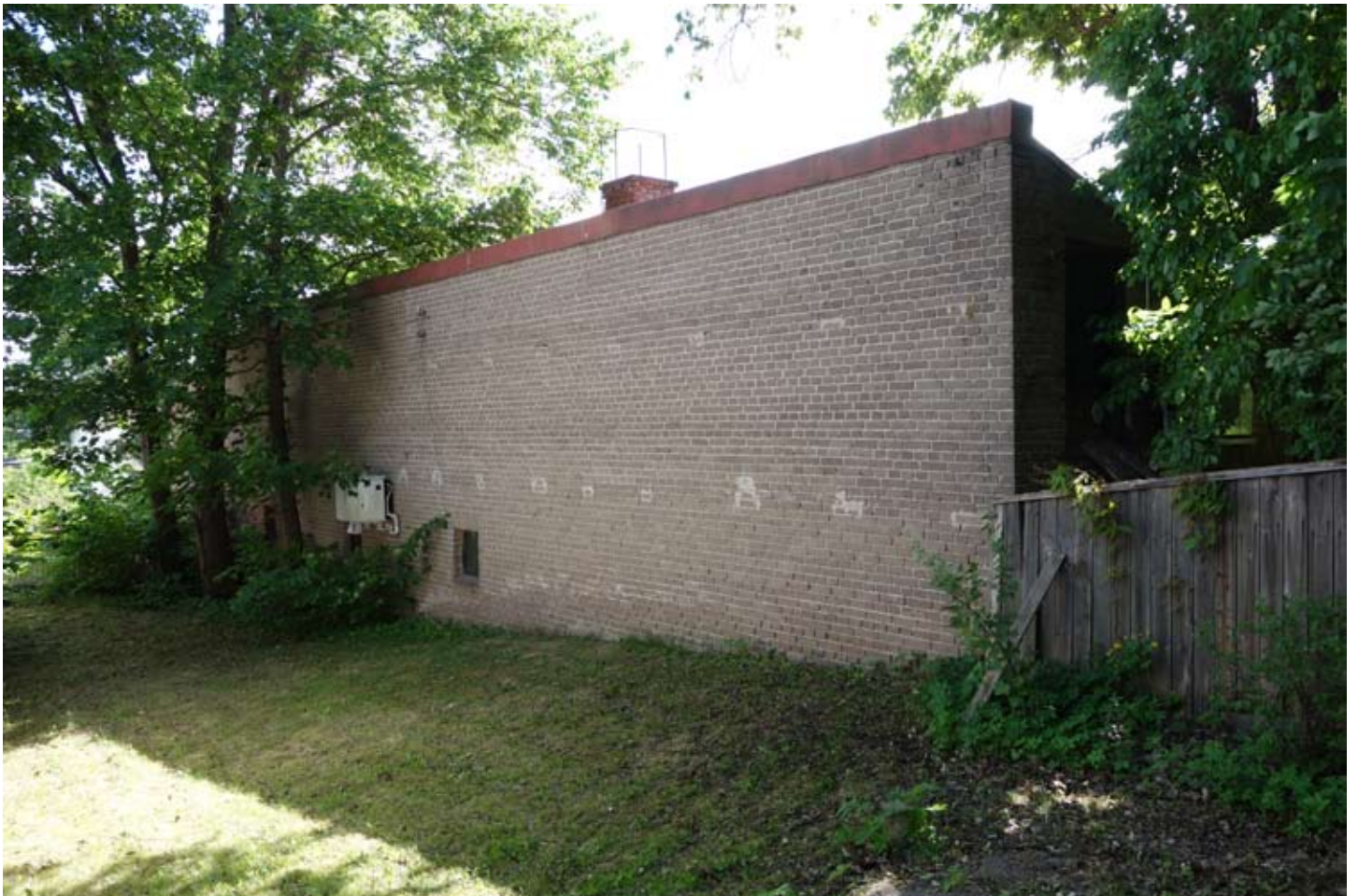
Tontti 37 Rakennus R6 palomuuuri
