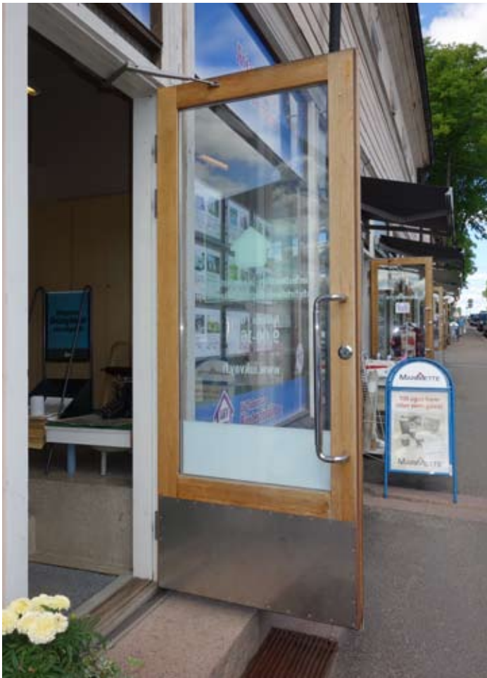
Tontti 36 Rakennus R1 liiketilojen uudistetut ovet
