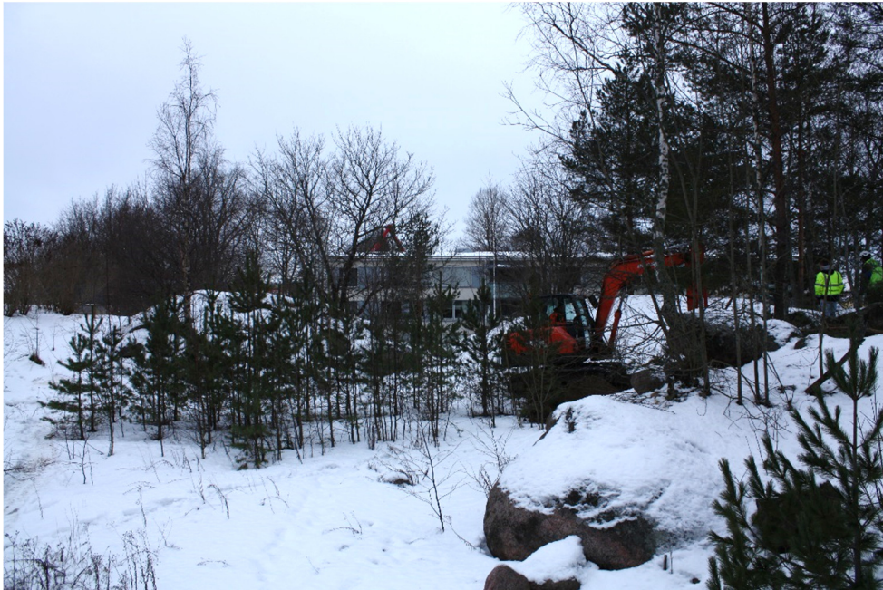
AKDG5145:2 Yleiskuva. Vallin koillis-lounaissuuntaiseen osaan kaivetaan koeojaa. Idästä. Kuva Katja Vuoristo.
