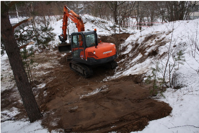
AKDG5145:23 Koeojaa täytetään. Pohjoisesta.
