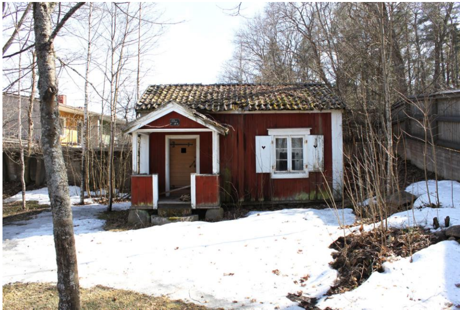
Kuva 35. Pihan perällä oleva puinen rakennus.
