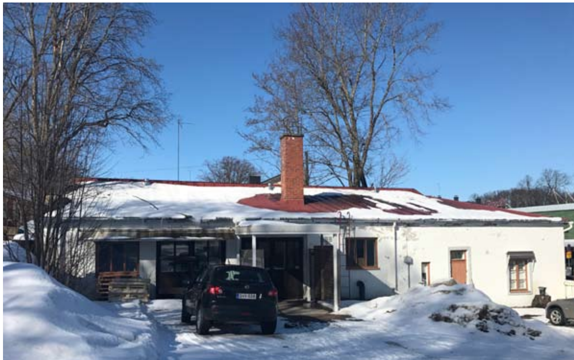
Rakennus R6 nykyasussaan sisäpihalta kuvattuna
