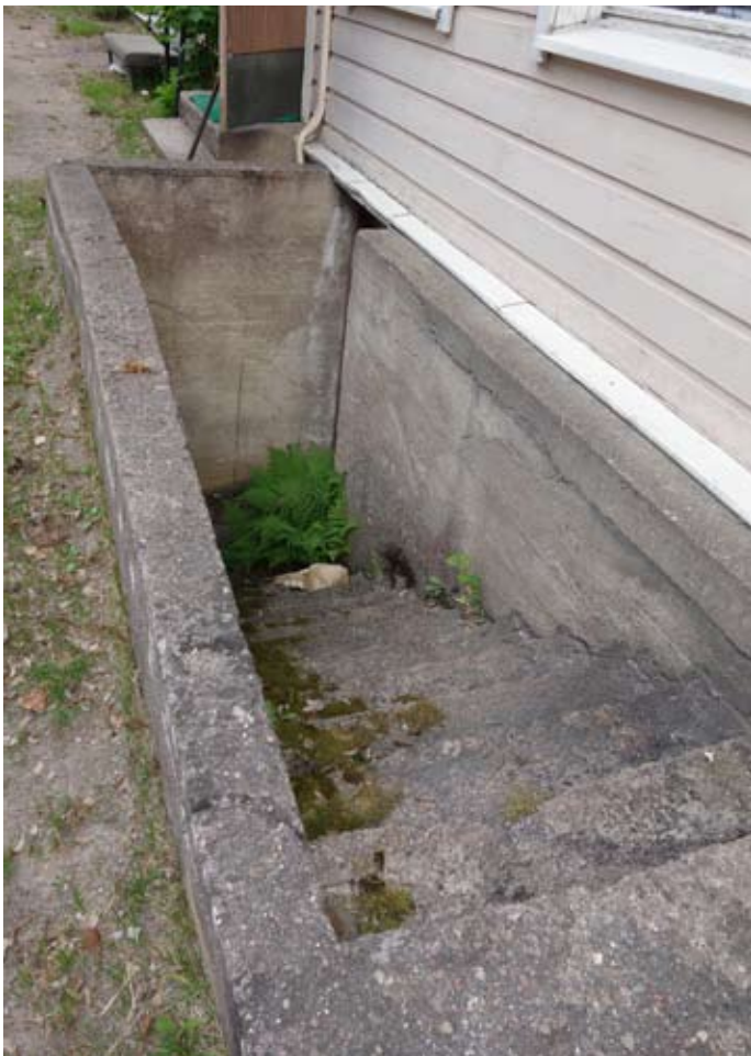
Tontti 36 Rakennus R1 portaat kellariin
