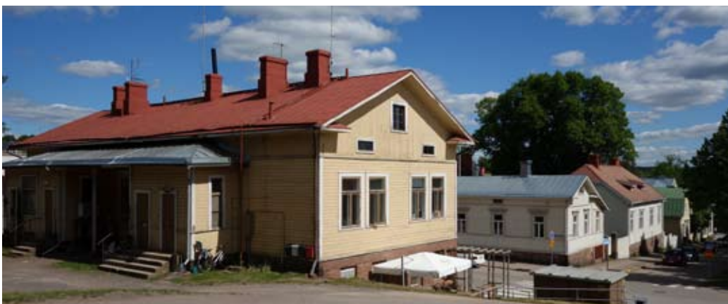
Rakennus R5 Pengermäkadun suunnasta nähtynä.
