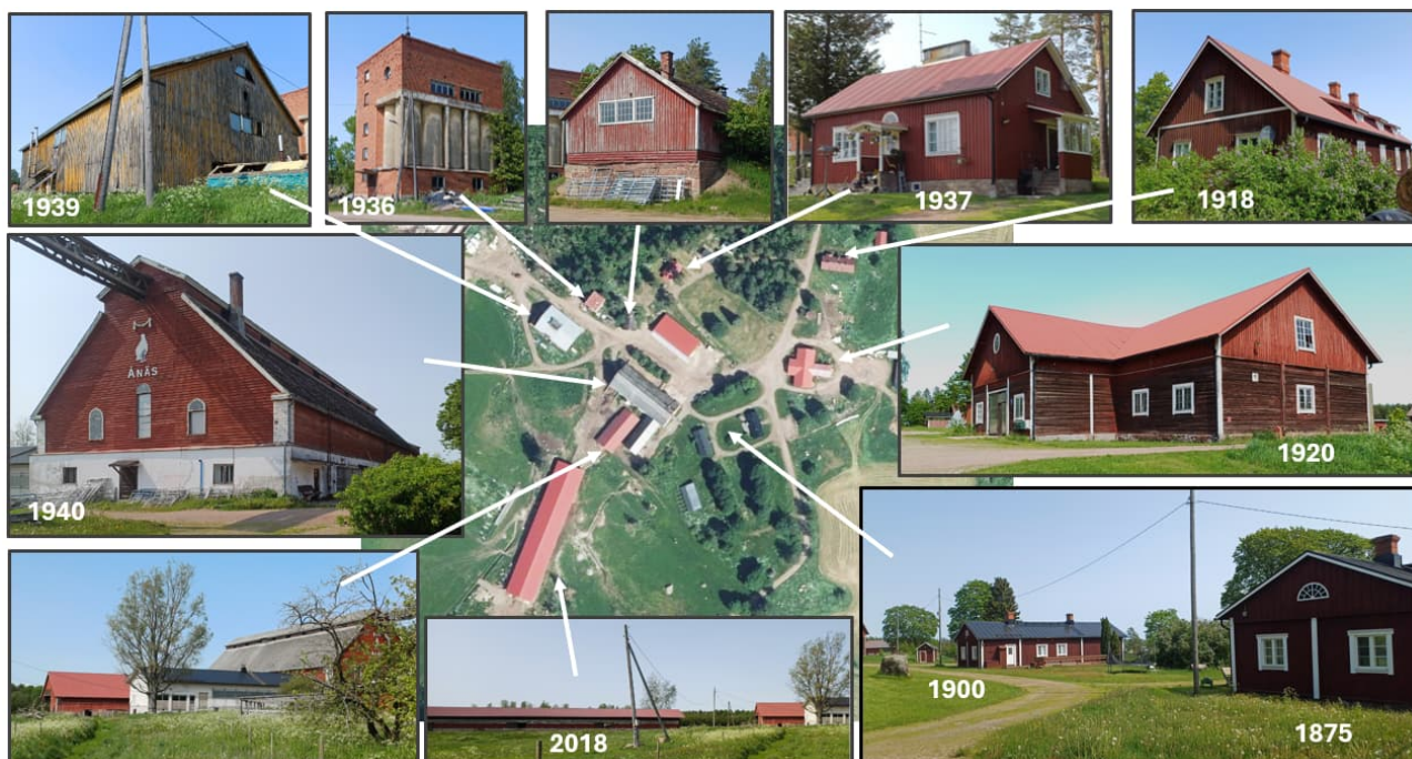
Kuva 1. Jokiniemen tilan rakennuksia. (Ilmakuva: MML, Valokuvat: Kajja Maunula, kesäkuu 2025)
