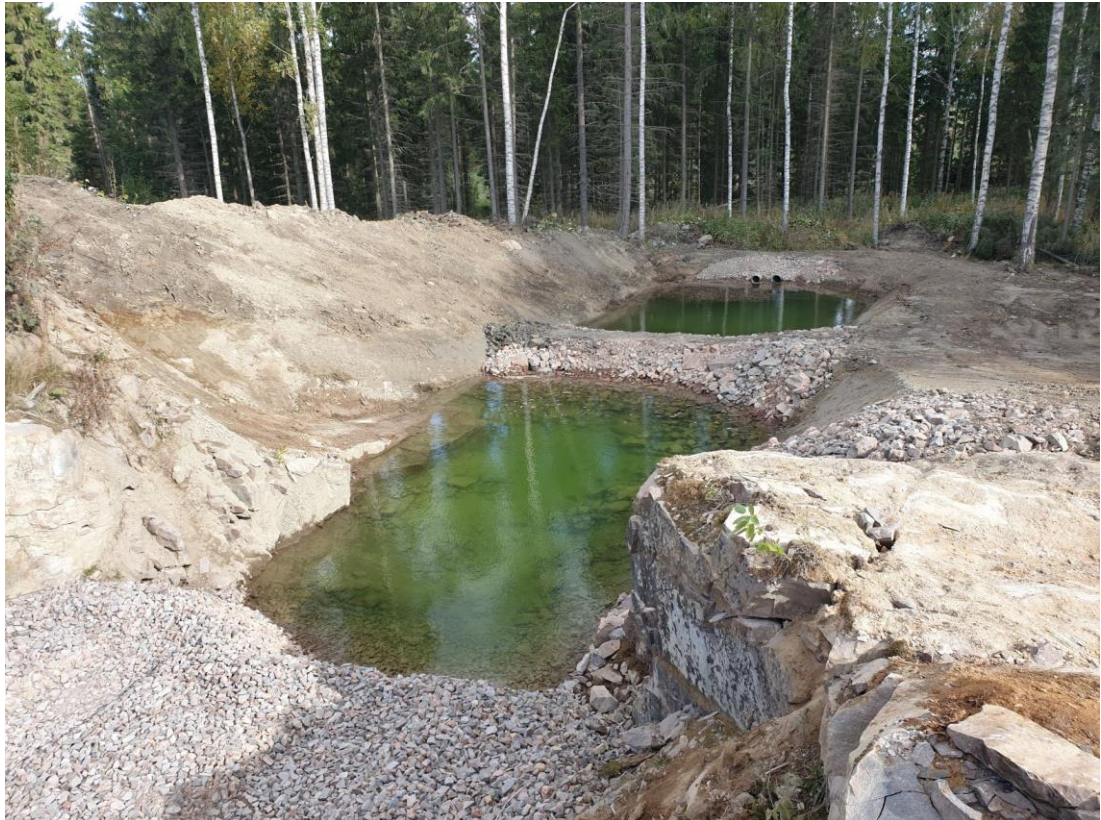
Kuva 36 b. Kallio-Malmgårdin hulevesien viivytyssallas. Bild 36 b. Regnvattnets sedimenteringsbassäng i Berg-Malmgård
