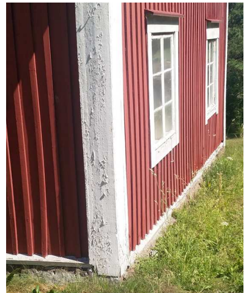
Bilder: Fasadmaterial samt problemet med låg grundmur/bergsytan som leder in regnvatten
