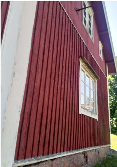
Bilder: Fasadmaterial samt problemet med låg grundmur/bergsytan som leder in regnvatten
