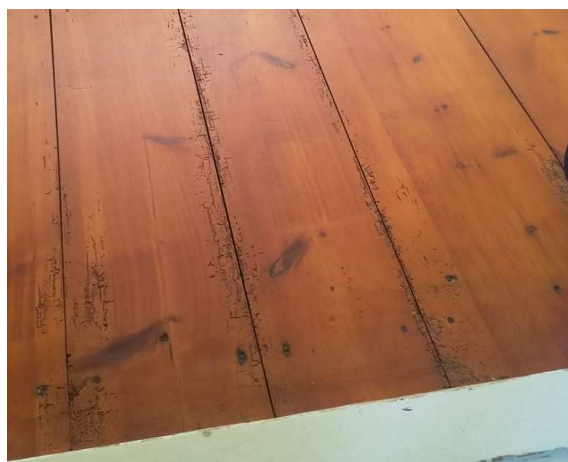
Bild: Insekt som skadat husets konstruktioner samt spår av skadorna (på golvplankor)
