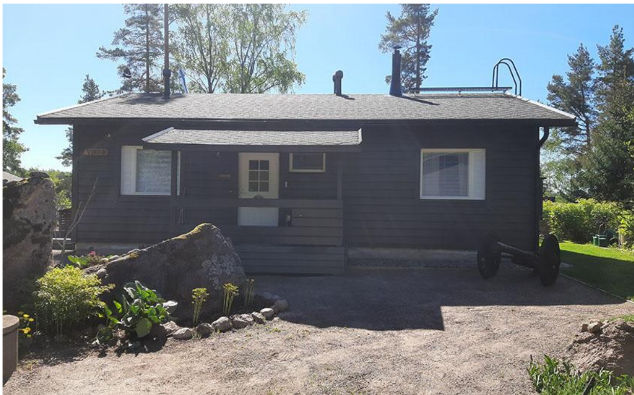
Kuva 13. Loma-asunnon julkisivu pohjoiseen.
