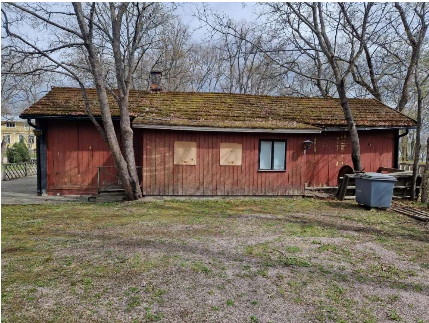
Kuva 52. Piharakennuksen julkisivu länteen.
