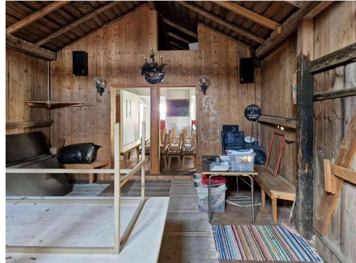
Kuva 57. Sisäkuva piharakennuksen eteläpäädyistä pohjoiseen päin.
