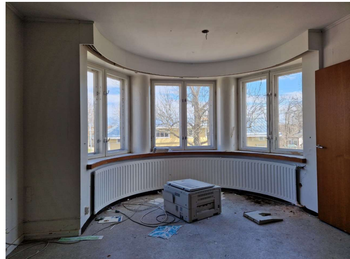
Kuva 44. Toisen kerroksen itäpäädyn erkkerihuone.
