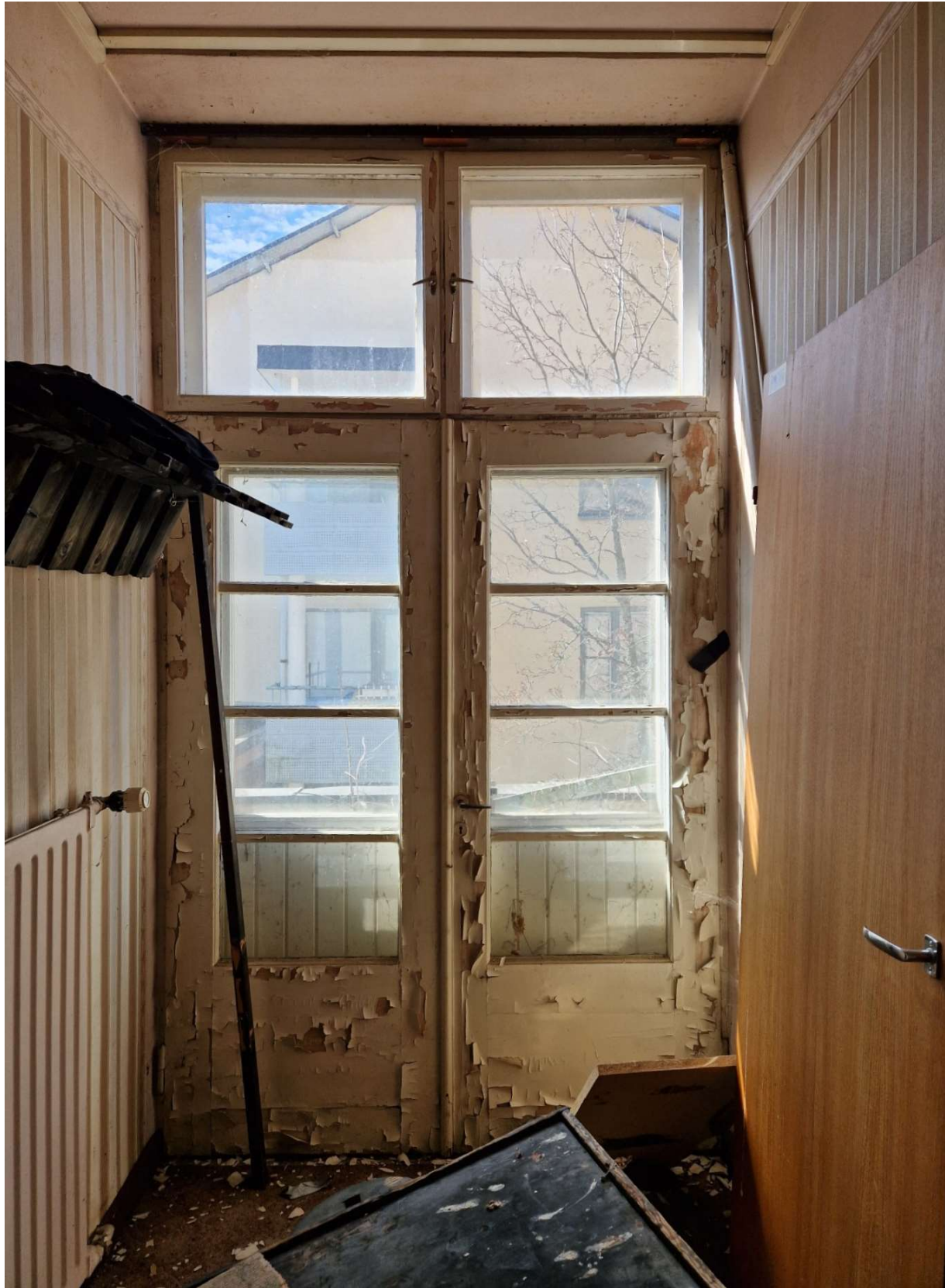
Kuva 49. Hotellikäytävän länsipäädyn ovi.
