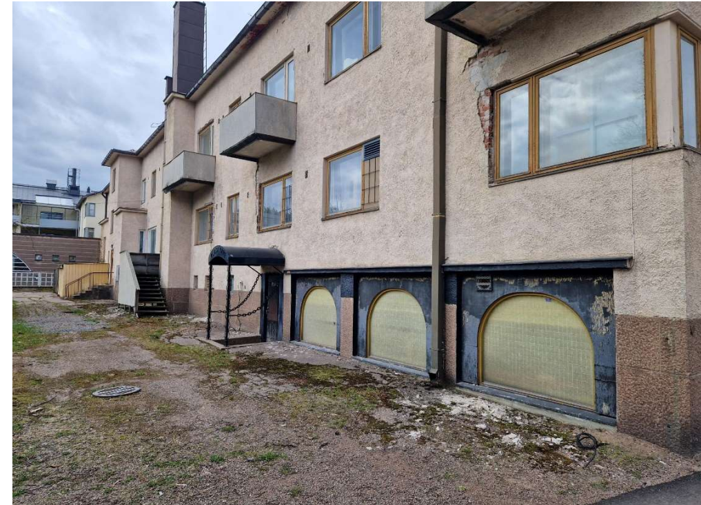
Kuva 27. Eteläjulkisivua. Toisen kerroksen parvekkeet ovat teräsbetonirakenteisia. Etualalla on kellarin uima-allasosastomuutoksen yhteydessä tehdyt kaari-ikkunat. Taaempana on uusi ulko-ovi portaineen vuodelta 1991.
