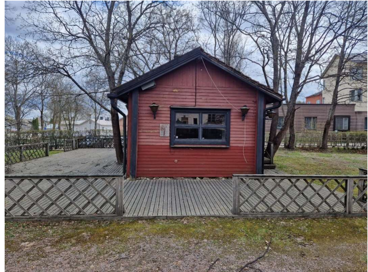
Kuva 53. Piharakennuksen julkisivu pohjoiseen.
