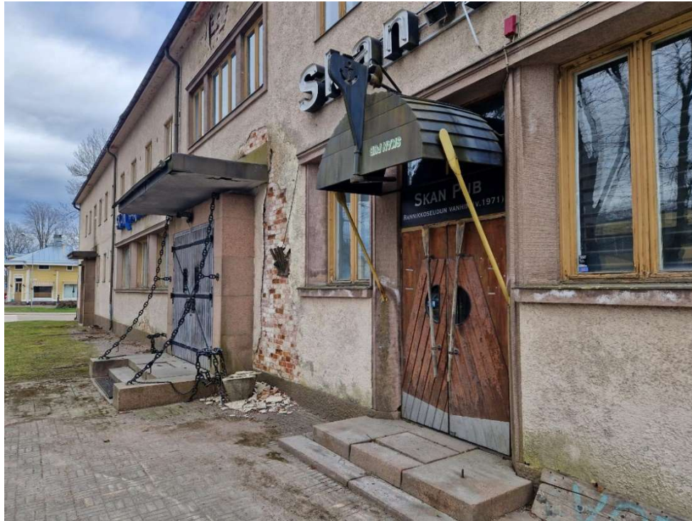
Kuva 25. Pohjoisjulkisivua. Etualalla Skan-Pubin ovi, joka on ilmeisesti alkuperäinen, mutta verhoiltu uudestaan vanerilla ja laudoilla. Se vasemmalla puolella on hotelli-ravintolan ovi, joka on uusittu. Sitä ja taaimpaa ovea kiertää graniittiharkot. Ikkunat ovat ravintolan ikkunoissa muita suuremman ja niiden ympärillä on terastirappaus samoin kuin etualan ovenpielissä.
