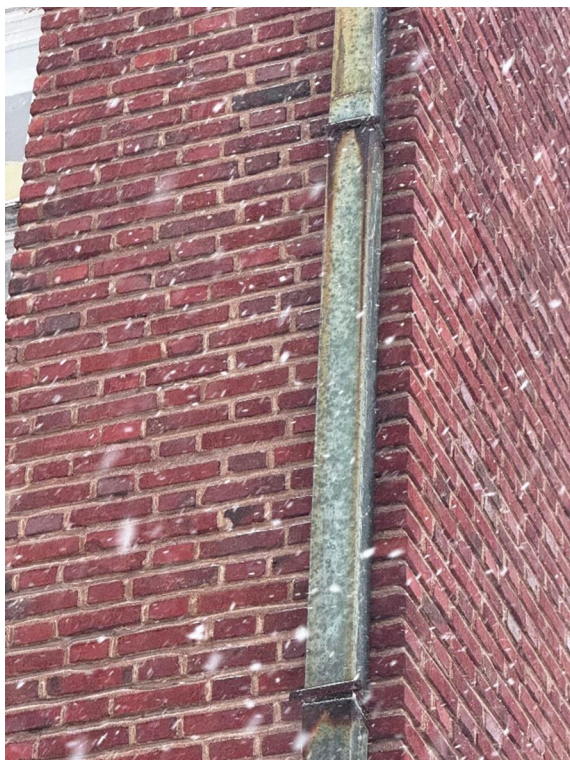
Kuva 6: Vaurioitunut syöksytorvi.
