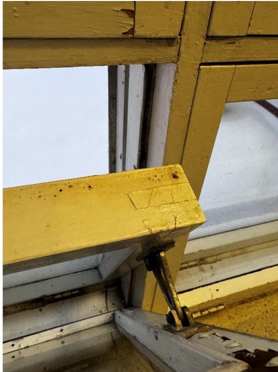
Kuva 30: Ikkunoiden tiivistyksissä ei havaittu merkittäviä puutteita.
