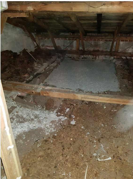
Kuva 39: Vesikattoa oli osittain korjattu
