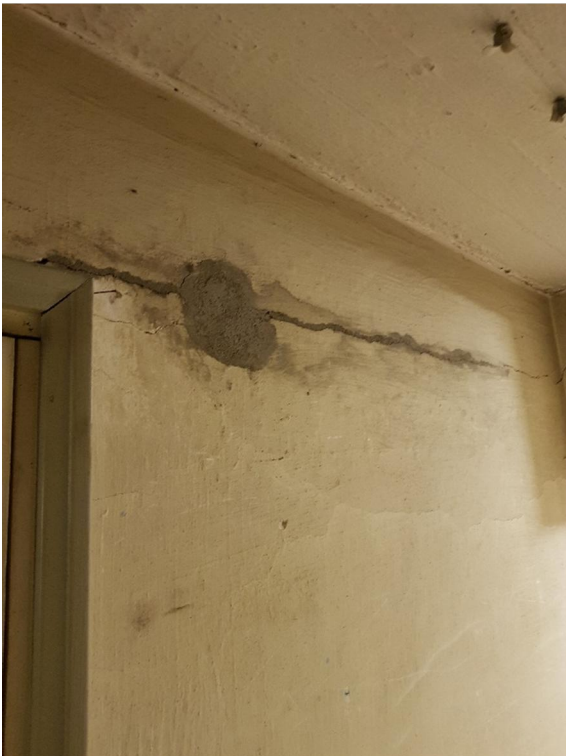
Kuva 10: Halkeama seinässä.
