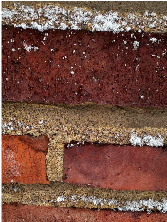
Kuva 19: Muuraussaumoja oli korjattu aiemmassa vaiheessa.
