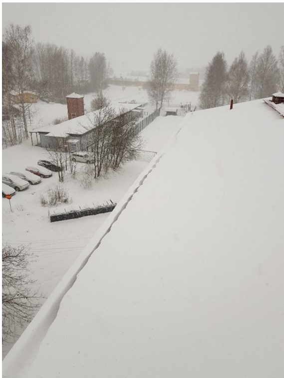
Kuva 35: Lumiesteiden määrä oli puutteellinen.
