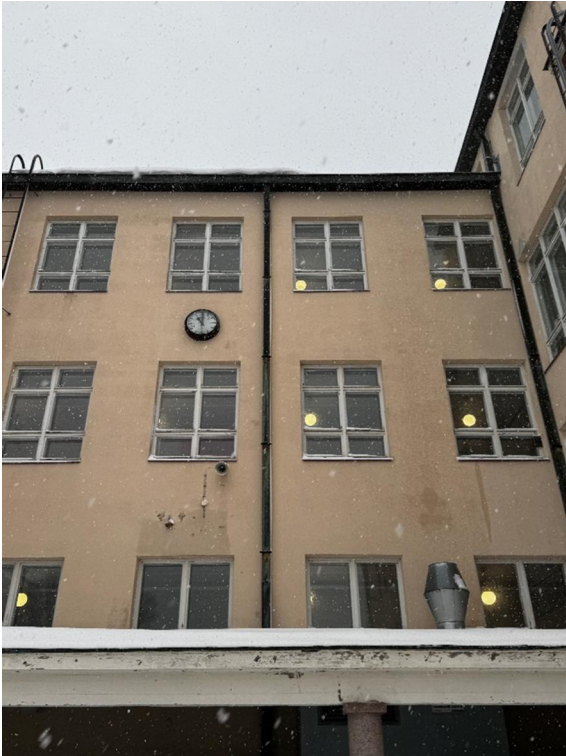
Kuva 14: Yleiskuva sisäänkäynnin julkisivusta.
