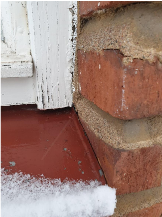
Kuva 31: Vesipellit ja kallistukset olivat hyvässä kunnossa
