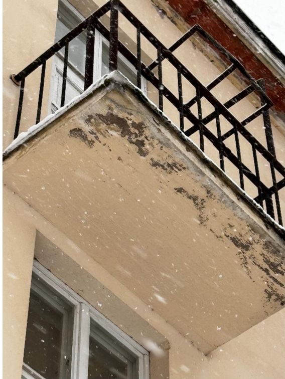
Kuva 21: Parvekelaatan vaurioita.
