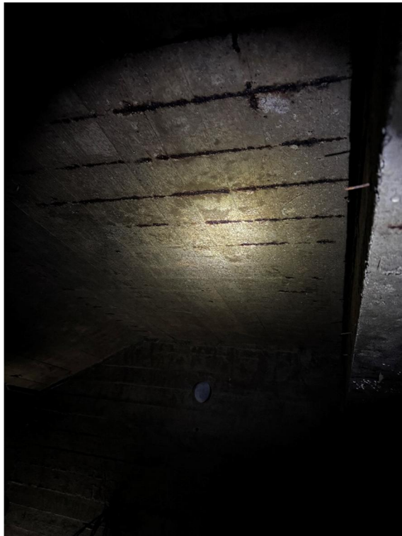
Kuva 11: Välipohjalaatan raudoitusvaurioita.
