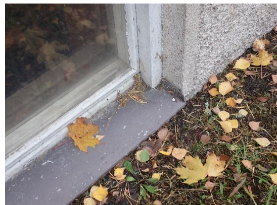
Kuva 17. Kellarin ikkunan liittymä perusmuuriin, lähellä maanpintaa
