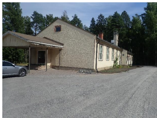
Kuva 42. Liikennealue ylärinteen puolella, pintavedet virtaavat rakennusta vasten.
