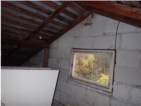
Kuva 13. Ulkoseinärakennne on ullakolla näkyvissä
