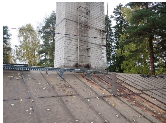
Kuva 28. Yleisnäkymä keittiö/asunto osan vesikatolle
