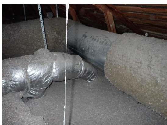
Kuva 36. Yleisnäkymä keittiön YP tilaan
