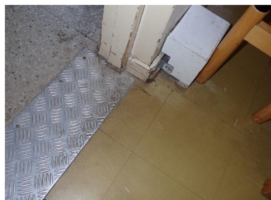
Kuva 12. Ala- ja välipohjarakenteen liittymänä ruokala/eteinen
