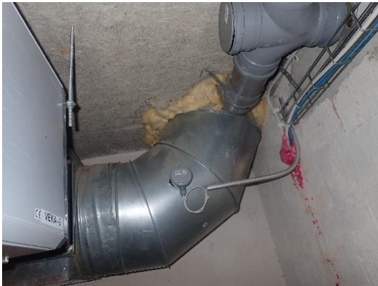
Kuva 23. IV kanava läpivienti välipohjasta, villa tilke tiivistyksenä
