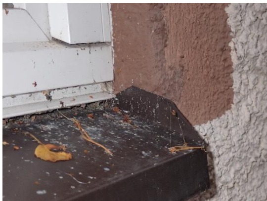
Kuva 16. Uuden ikkunan vesipeltiliitos
