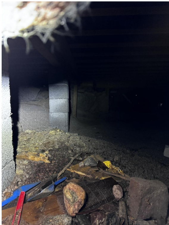
Kuva 11: Alapohjan harkkoperustuksia.
