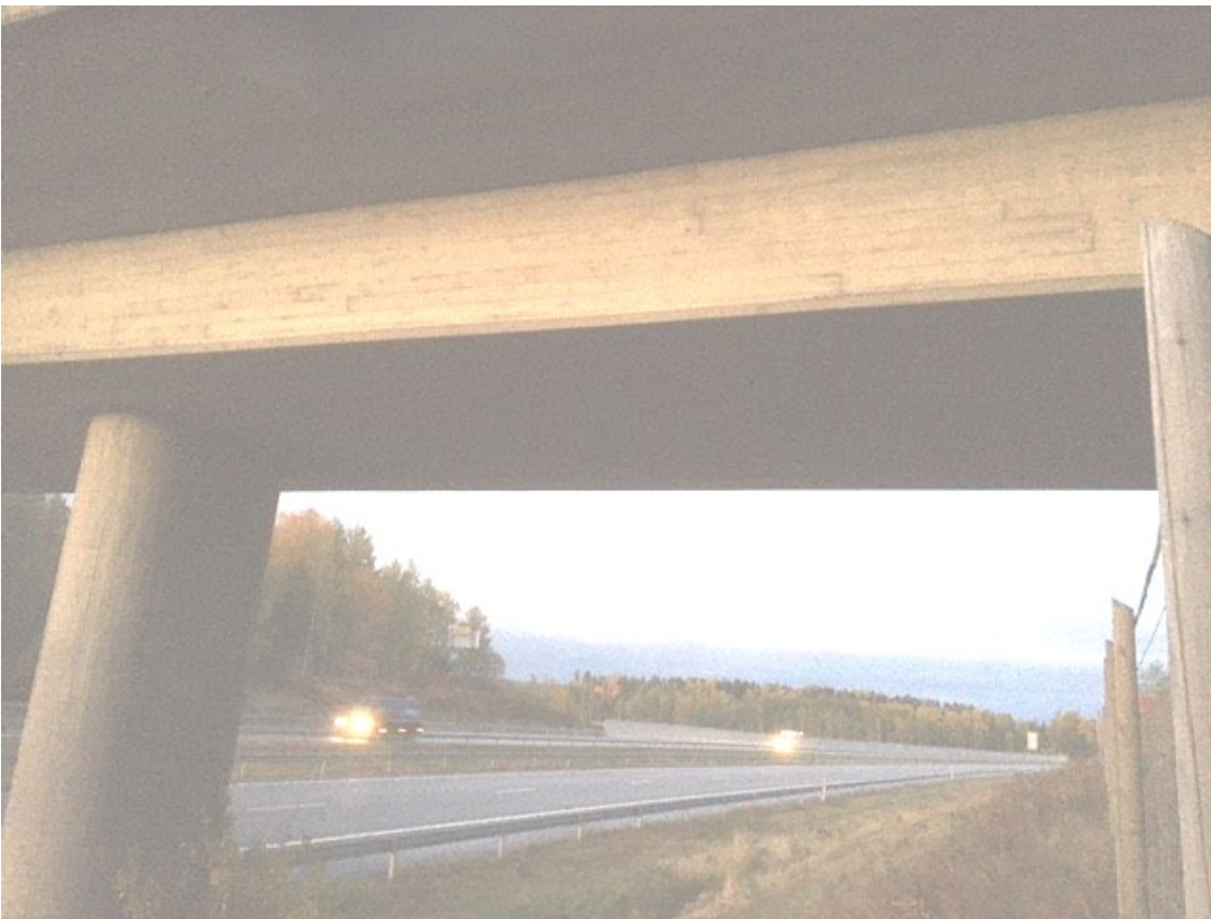
Kuva 11. Ajoneuvoliikenteen silta eteläpuolelta itään päin nähtynä.
