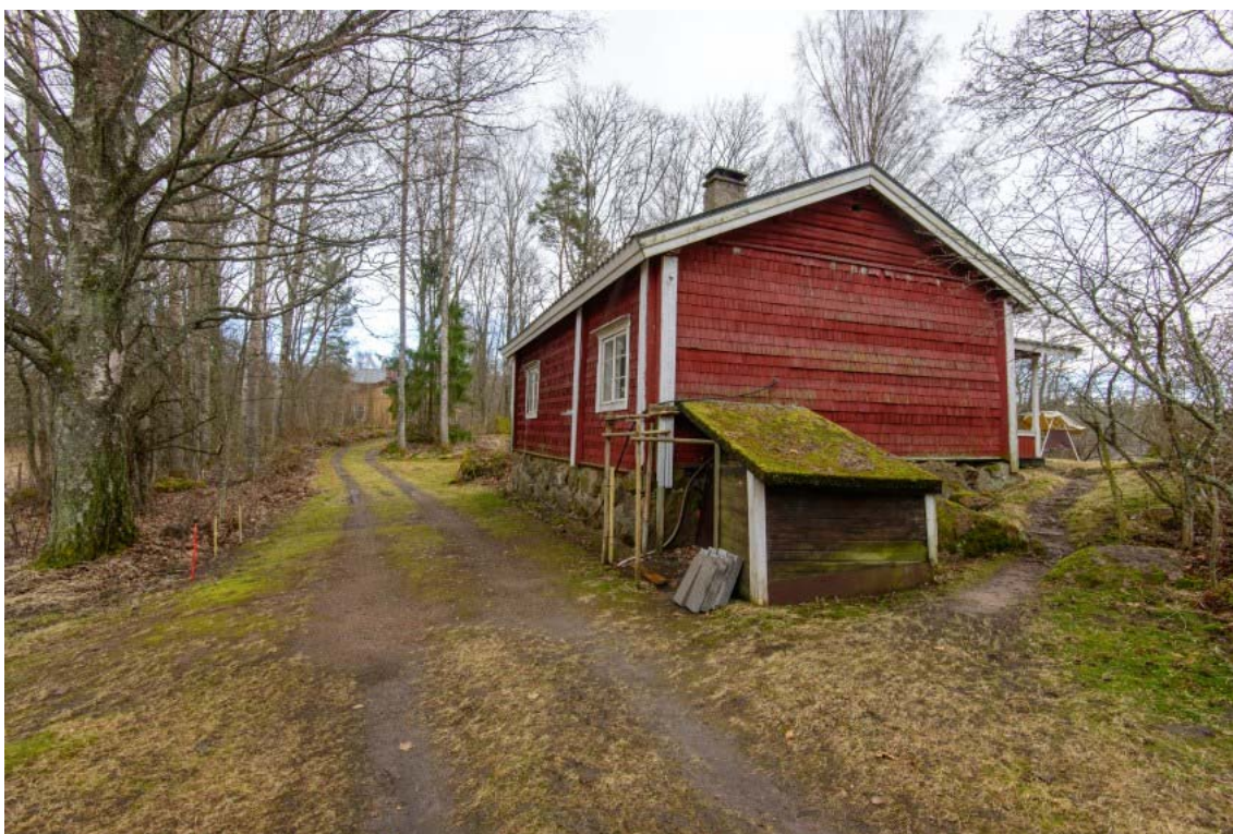
AKDG5422:4 Aluetta Fantsnäsin päärakennuksen pohjoispuolella. Kuva pohjoisesta.
